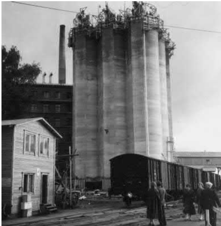
Alla Palmqvistin betonisiilot rakennusvaiheessa 1958. Vaasan kaupungin keskusarkisto / Pohjanmaan museo.
