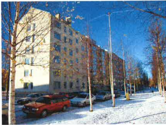
C-porras etualalla, taka-alalla A- ja B-porras
