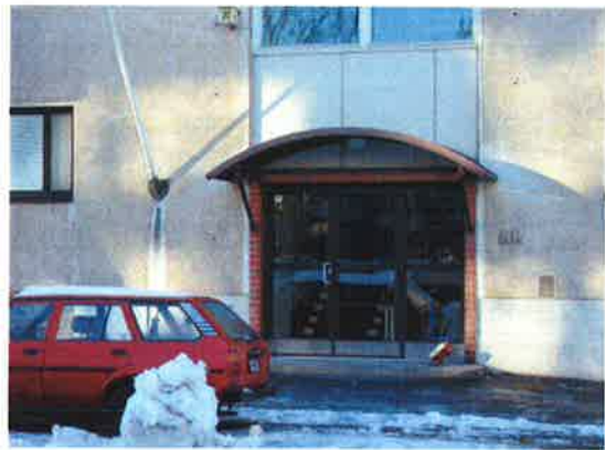
Rakennus A, ulko-ovi
