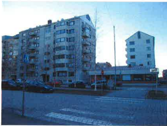
Rakennukset A ja B
