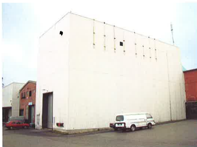
Kuva 24. Varastorakennus (uusi kellariosasto) luoteesta nähtynä.
