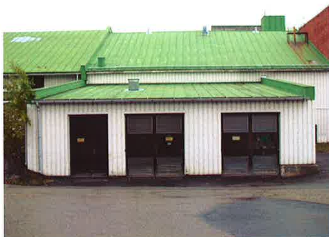
Kuva 16. Kattilahuoneen laajennuksen itäjulkisivu.
