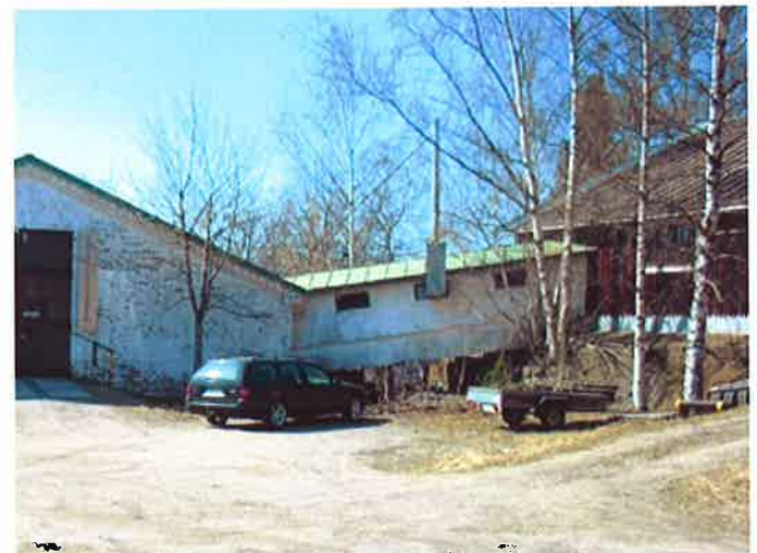
Kuva 37. Mattokutomoa ja varastorakennusta yhdistävä katettu kuljetushihna on vuodelta 1955.
