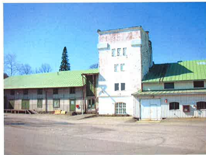
Kuva 11. Mallastamon ja keittämön itäjulkisivua. Keskellä mallastamon kuivaamo.
