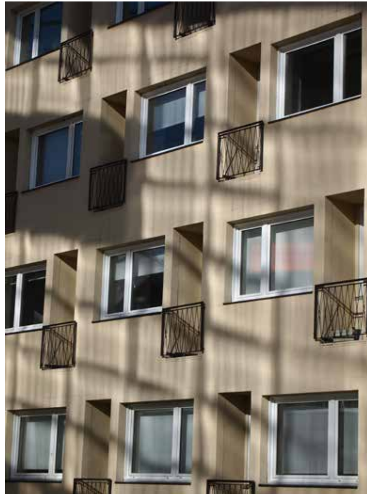
I-rakennuksen kaakonpuoleisen julkisivun rytmistä aukotusta.
