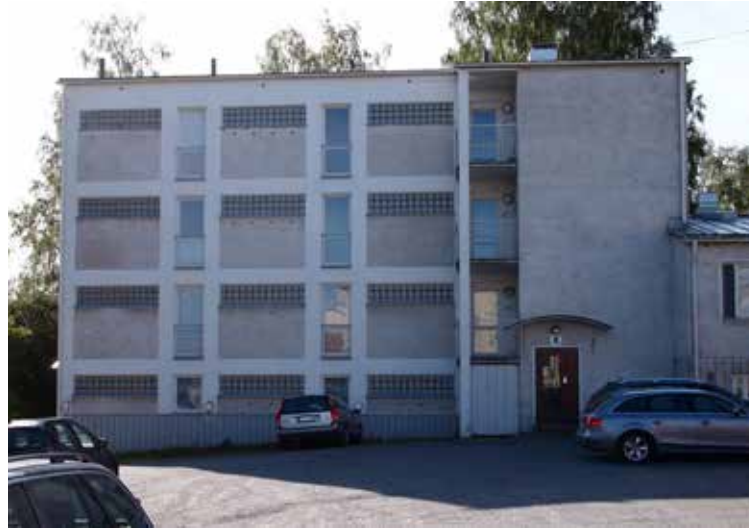
X-rakennuksen Hietalahden kadun varren paikoitusalueelle aukeava julkisivu X3. on sommitelultaan harkittu.
