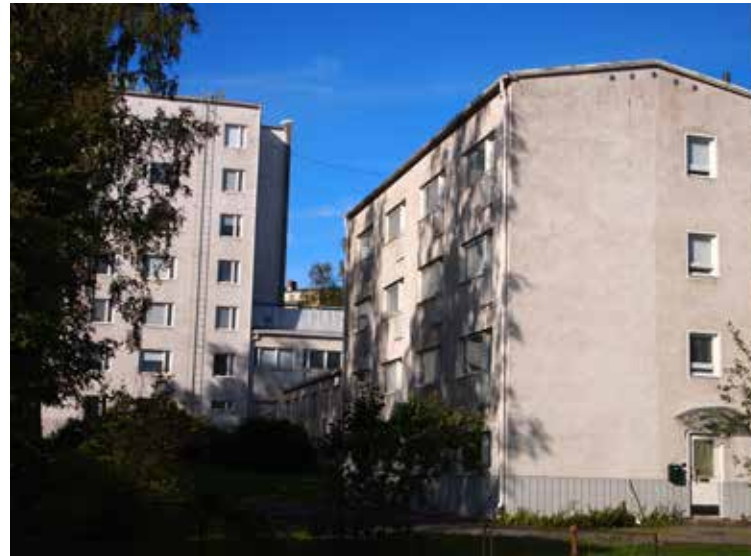
X-rakennus kuvattuna idän puolelta, Sanmarkinkadulta.
