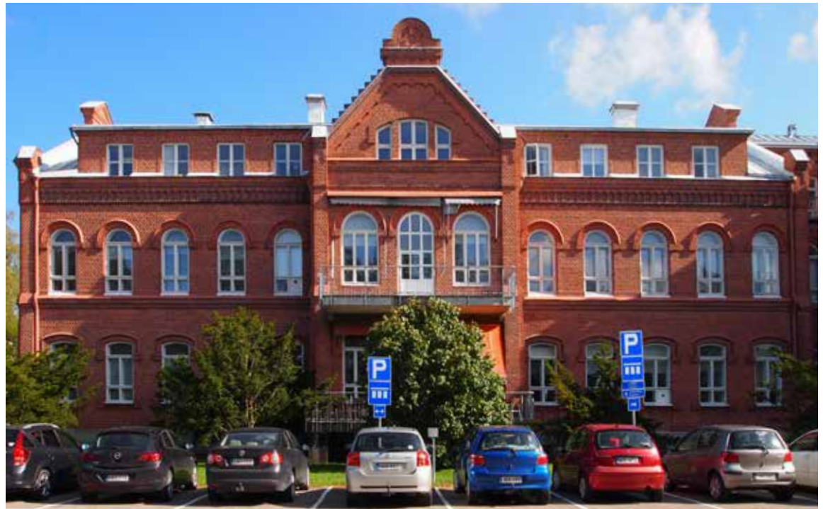
J-rakennuksen merenpuolinen julkisivu. Vinttikerros on lisätty 1930-luvulla.
