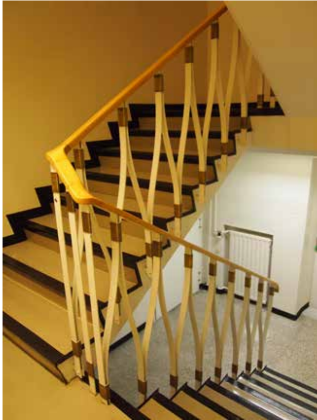
M-rakennuksen kellarikerrokseen vievän portaikon kaide on erittäin hienosto muotoiltu.
