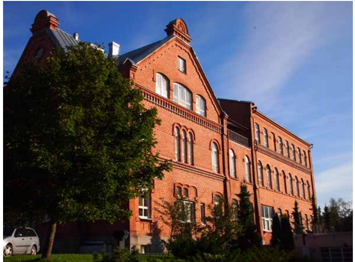
J-K-rakennuksen etelänpuoleista julkisivua korotettiin oikeanpuoleiselta osaltaan yhdellä kerroksella 1930-luvun lopulla.
