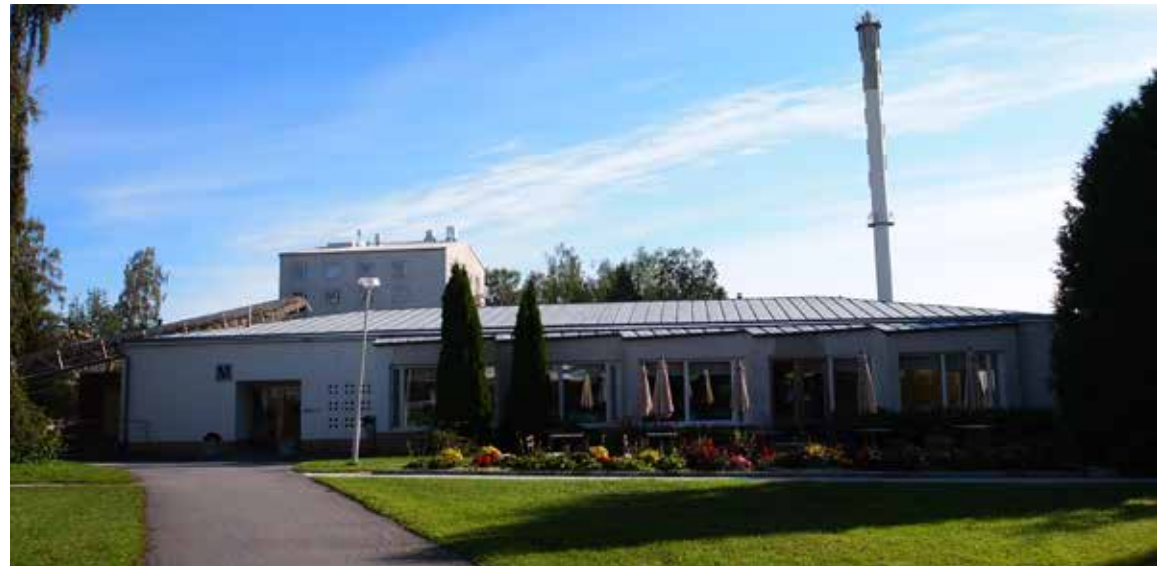
Ruokala-rakennuksen pääjulkisivu länteen. Takana vasemmalla näkyy X-rakennuksen torniosaa.
