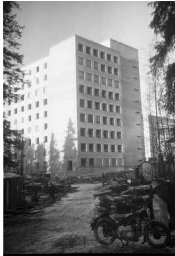
ABC-rakennuksen potilastorni kuvattun sen vasta valmistuttua 1950-luvun puolessa välissä.(PM)
