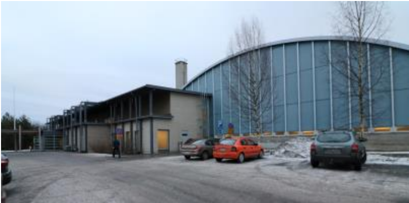
Kuva 8 Uimahallin julkisivu Hietalahdenkadulle vuonna 2017. Pohjanmaan museon arkisto.
