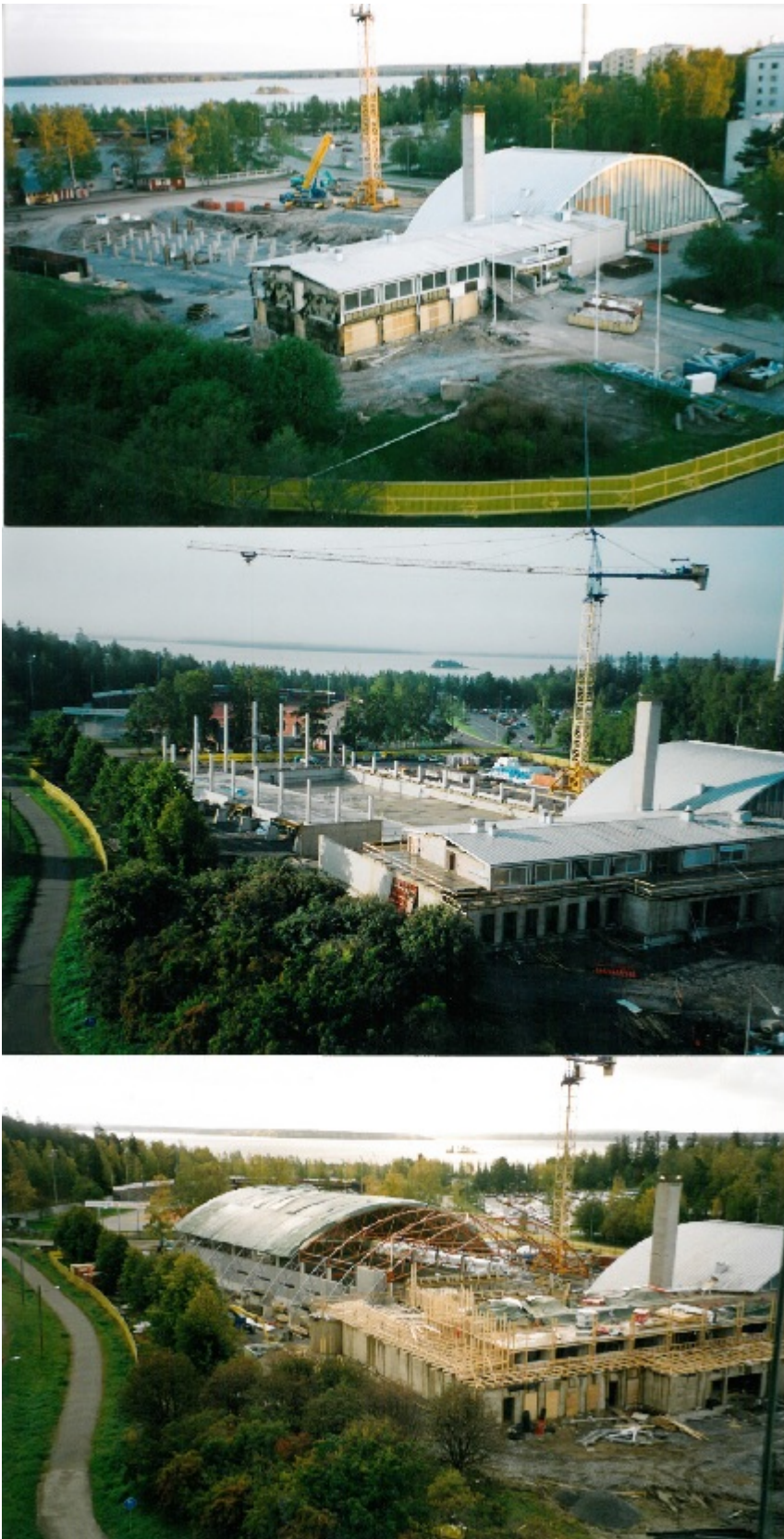
Kuva 7 Kuvasarja uimahallin laajennustyöstä. Pohjanmaan museon kuva-arkisto.
