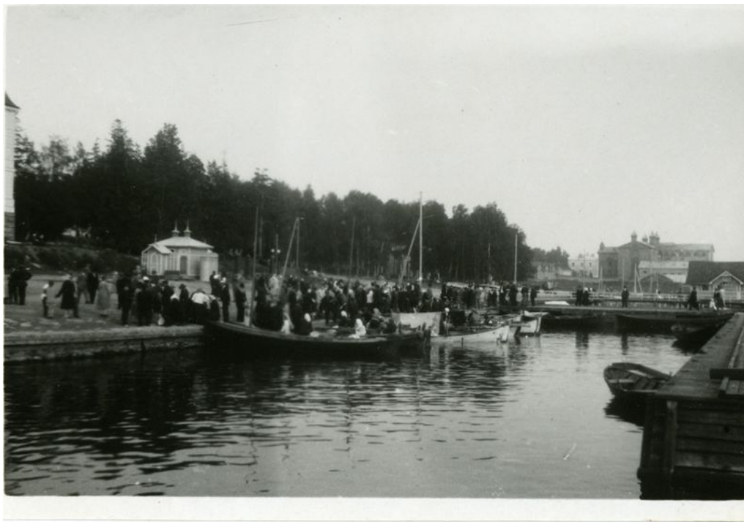
Ihmisiä nousemassa Kalarantaan vuonna 1930. Kuvan vasemmassa laidassa näkyy entisen vesiylöikeuden rakennuksen lisäsiipi ja sen oikealla puolella vanha käymälärakennus (purettu). Kuvan oikeassa laidassa on yksi laiturialueen uimalarakennuksista (purettu) ja sen takana Vaasan vankila. Kuvalähde: Pohjanmaan museo / Nyblin
