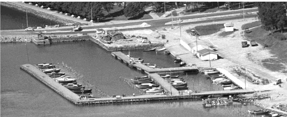
Ote ylemmästä kuvasta, kohdistuen Kalarantaan. Vanha kalahalli ja käymälärakennus on jo purettu ja uusi kalahalli lähes lopullisessa laajuudessaan. Wolffin laiturialueella näkyy vielä useita vanhoja aittarakennuksia. Kuvalähde: Vaasan kaupungin kaavoituksen arkisto
