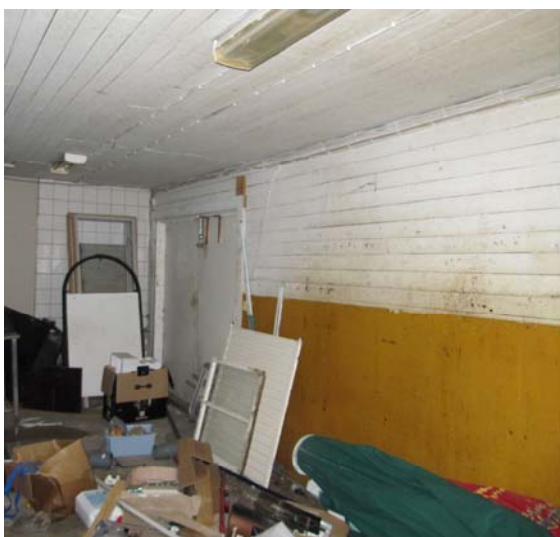
Kalahalli vuonna 2016. Osa sisäseinistä on paneelipintaisia ja maalattuja, osa eri aikoina levytettyjä. Suuri osa lattiaista on betonipintaisia.
