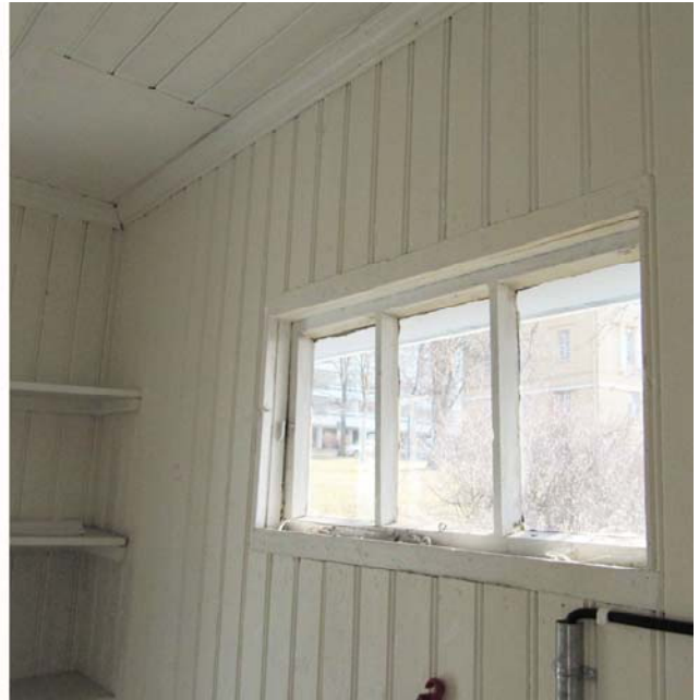
Satamanvartijan kopin sisätiloja vuonna 2016. Seinä- ja kattopintojen helmiponttipaneelit ovat todennäköisesti alkuperäisiä.
