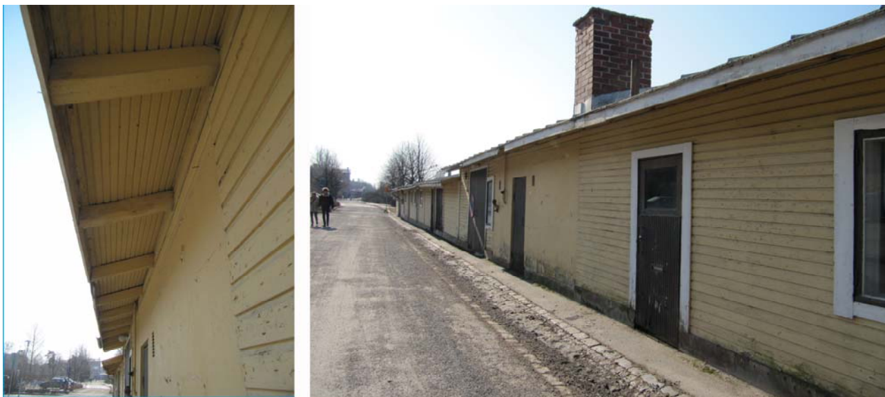
Kalahallin idänpuoleinen julkisivu kuvattuna vuonna 2016 pohjoisesta etelään päin. Kuvassa etualalla olevat julkisivun osat on kauttaaltaan rakennettu uudelleen 1950-luvun puolivälissä, samassa yhteydessä, kun rakennukseen rakennettiin kattilahuone. Kivirakenteinen, rappauspintainen kattilahuone on kuvan puolivälissä. Kuvalähde: Vaasan kaupungin kaavoituksen arkisto
