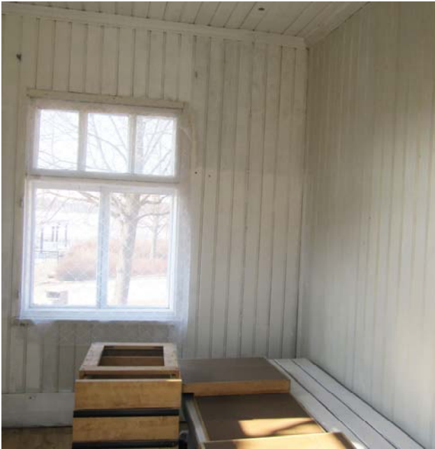
Satamanvartijan kopin sisätiloja vuonna 2016. Seinä- ja kattopintojen helmiponttipaneelit ovat todennäköisesti alkuperäisiä.
