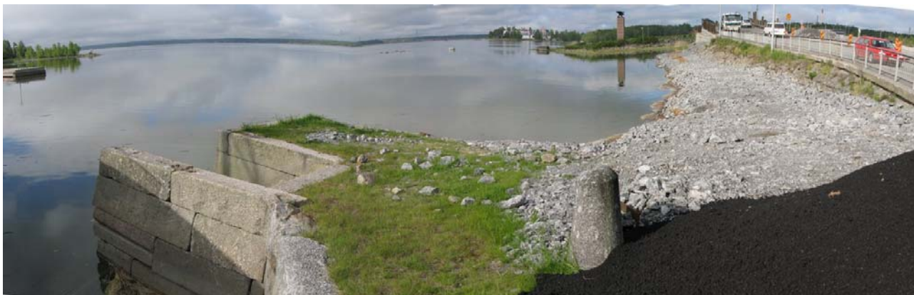
Wolffin laiturin jäännös kuvattuna vuonna 2012 ennen Vaskiluodon sillan uusimista. Museo edellytti laiturin säilyttämistä vahingoittumattomana. Kuvassa etualalla näkyy kivipaasi, jonka on edellytetty säilyvän osana laituria, mutta joka muutostöiden jälkeen on jätetty palauttamatta paikoilleen. Lähempänä tietä sijainneet portaat on joko peitetty soralla tai purettu. Kuva Pohjanmaan Museo / Kaj Höglund 2012.
