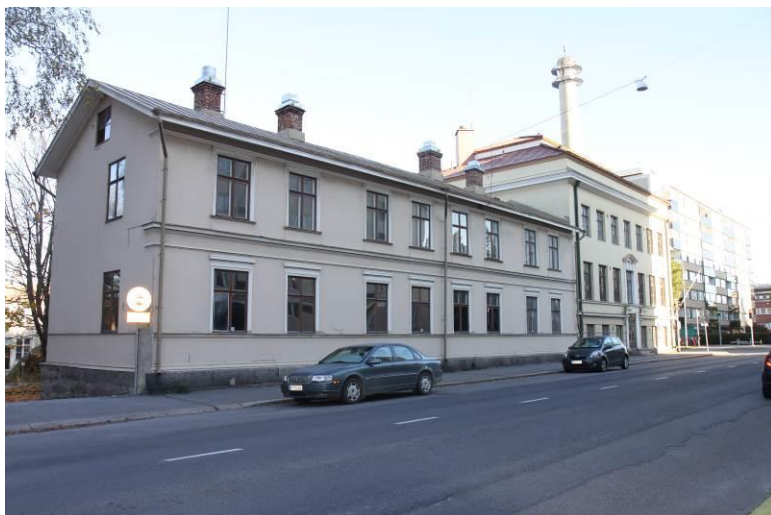
Kuva 1 Toimistorakennuksen Museokadun puoleinen julkisivu, rakennuksen vanhempi osa.
