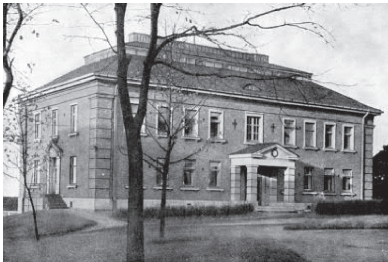
Puuvillakonttori, Puuvillakuja 8. Teoksesta Vaasan Puuvilla Oy 80 vuotta.
