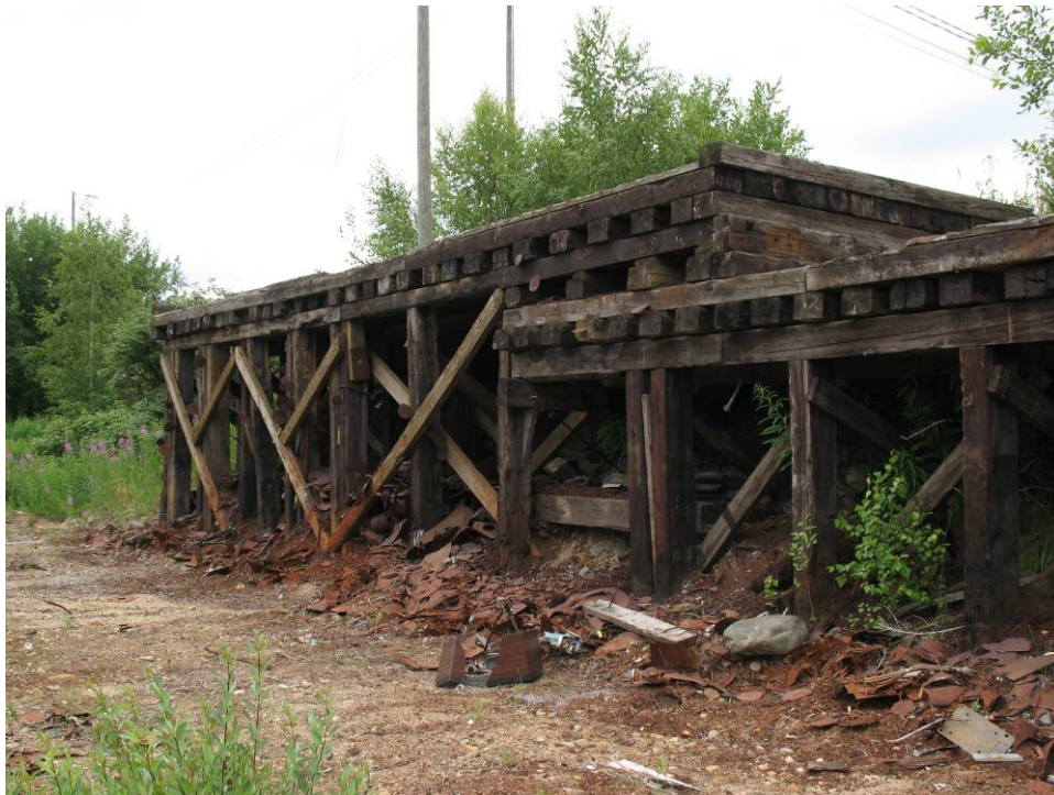
Kuva: purettuun rautatieosuuteen liittynyt laiturirakennelma on säilynyt.
