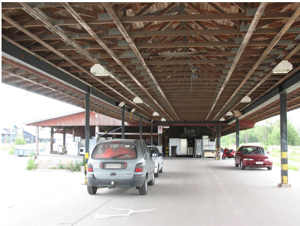
Kuva: tavara-aseman vuonna 1991 rakennettu katos ja laituri.
