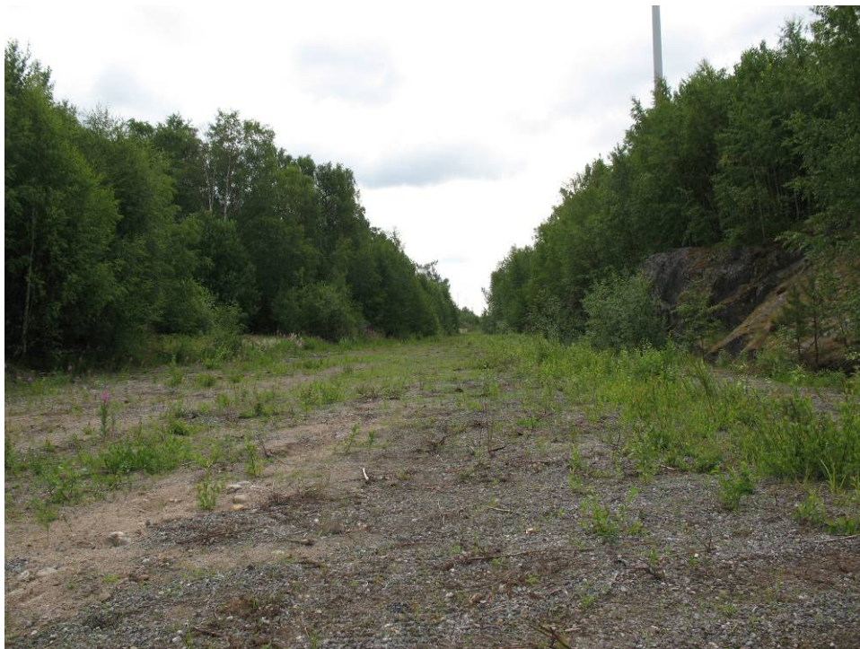
Kuva: rautatien vanhaa linjausta, kiskot purettu. Linjaus on louhittu kallioon. Korkeimmalla kohdalla telemasto (kuvassa oikealla).
