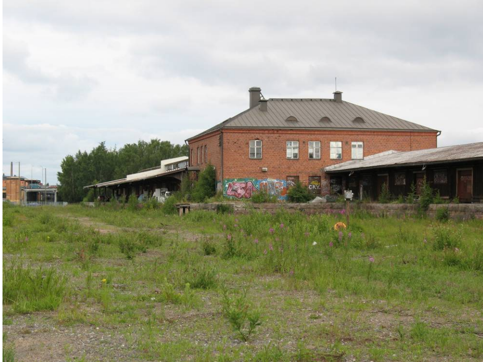
Kuva: tavara-asema kuvattuna radan puolelta kohti Maasiltaa. Kuvaajan paikalta rataiskot purettu.
