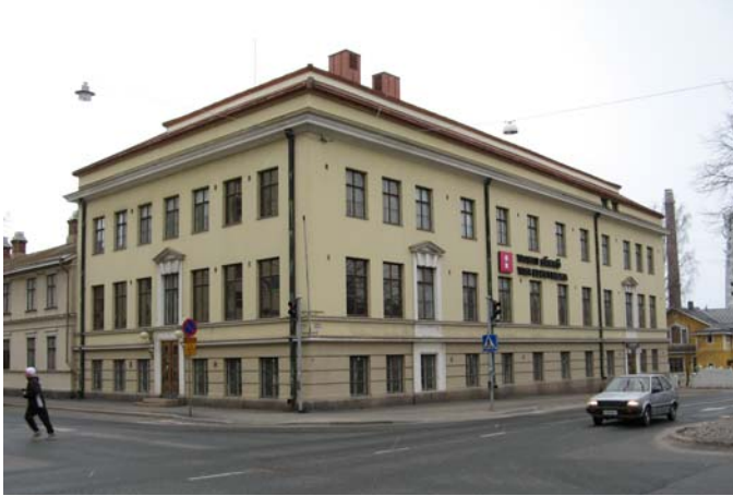
99. Kirkkopuistikko 4/Museokatu 7 - Vaasan sähkön konttorirakennus
