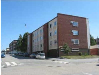
168. Pitkänlahdenkatu 21/Laivakatu 6 - Kiint. oy Laiva-Haka
