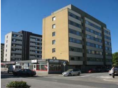
65. Kauppapuistikko 26/Kasarminkatu 12 - as oy Vaasan Kasarmikatu 12 A
