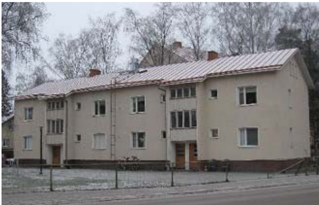
24. Skoonenkatu 2 C-D- Skånegatan 2 C-D. Rakennukset ovat rakennushistoriallisesti ja maisemallisesti arvokkaita.
