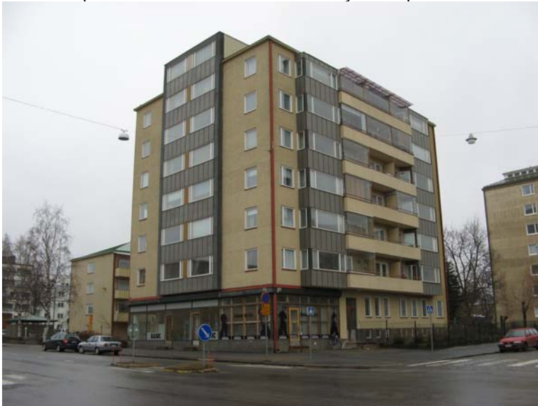
94. Kirkkopuistikko 29/Rauhankatu 10 - As oy Kirkkopuistikko 29
