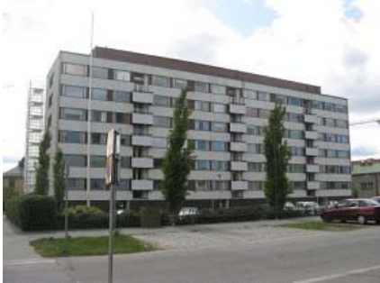
190. Raastuvankatu 50-52/Tiilitehtaankatu 12 - As oy Raastuvankatu 50 – 52
