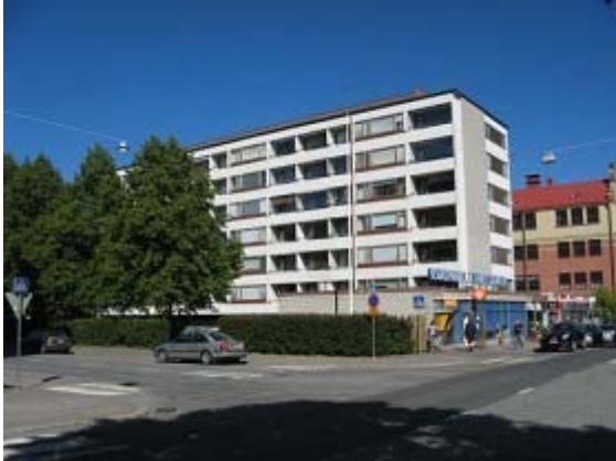
Suunn. Arkkitehti Erik Lindroos 1963. Rakennuksella on ympäristöarvoa.
