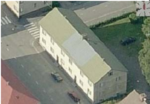
33. Asemakatu 43/Lastenodinkatu 2 - As oy Asemakatu 43
