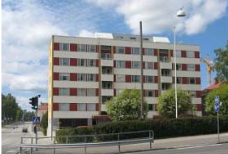
194. Raastuvankatu 58/Hietalahdenkatu 11 - As oy Hietalahdenkatu 11
