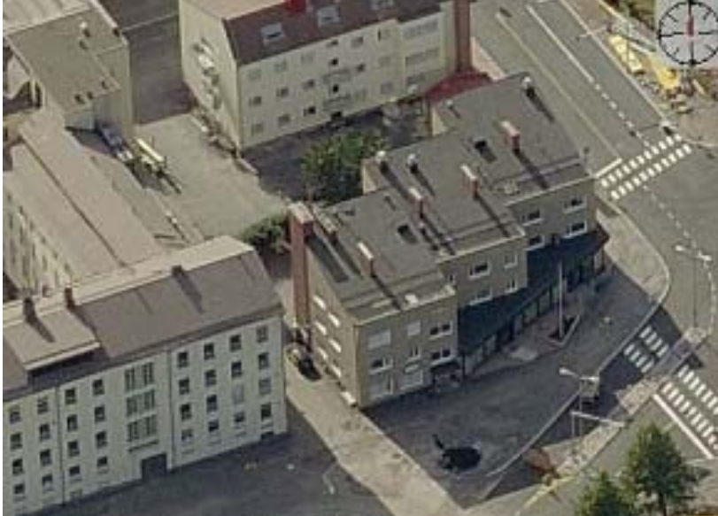
45. Hietasaarenkatu 24/Rosteninkatu 4 - Kiinteistö oy Rosteninkatu 4 suunn. Pauli Saravirta 1954. Rakennuksella on ympäristöarvoa. Kuva Pictometry.
