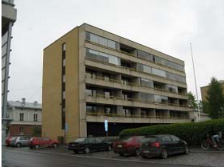
137. Koulukatu 62/Tiilitehtaankatu 4 - As oy Koulukatu 62
