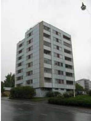
192. Raastuvankatu 55/Tiilitehtaankatu 12 - As oy Raastuvankatu 55
