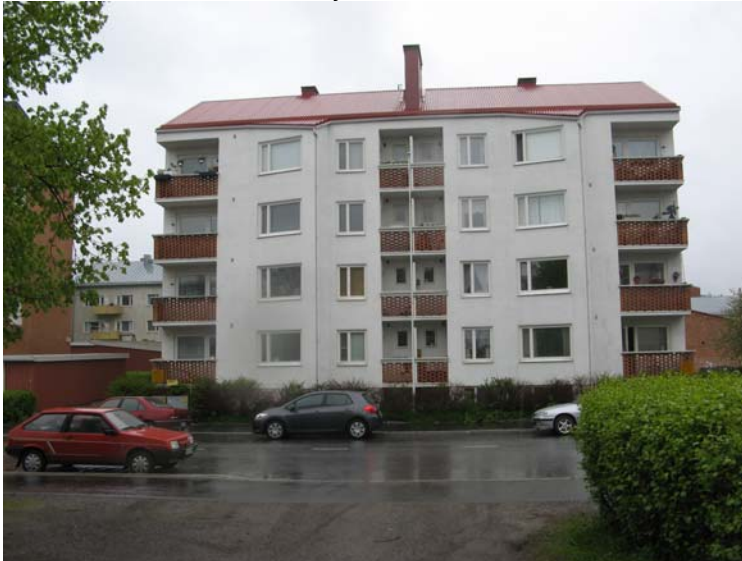
38. Hietalahdenkatu 29 - As oy Hietalahdenkatu 29
