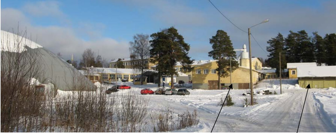
Puutyöpajan rakentaminen käynnistyi 1957 alussa. Puutyöpaja. Oikealla I. Sereniuksen suunnittelema tuoreen puun varasto vuodelta 1954.
