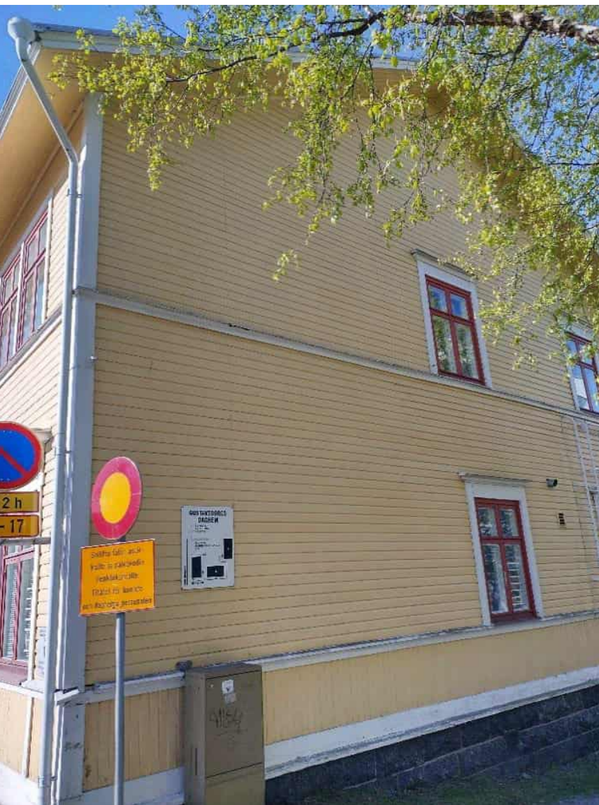
Kuva 17 Luoteis- ja kaakkoispäädyt, kuvat vuodelta 2021
