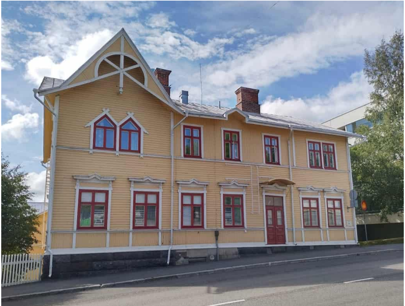
Kuva 5 Koulukatu 56 katurakennuksen koillinen julkisivu, kuva vuodelta 2021
