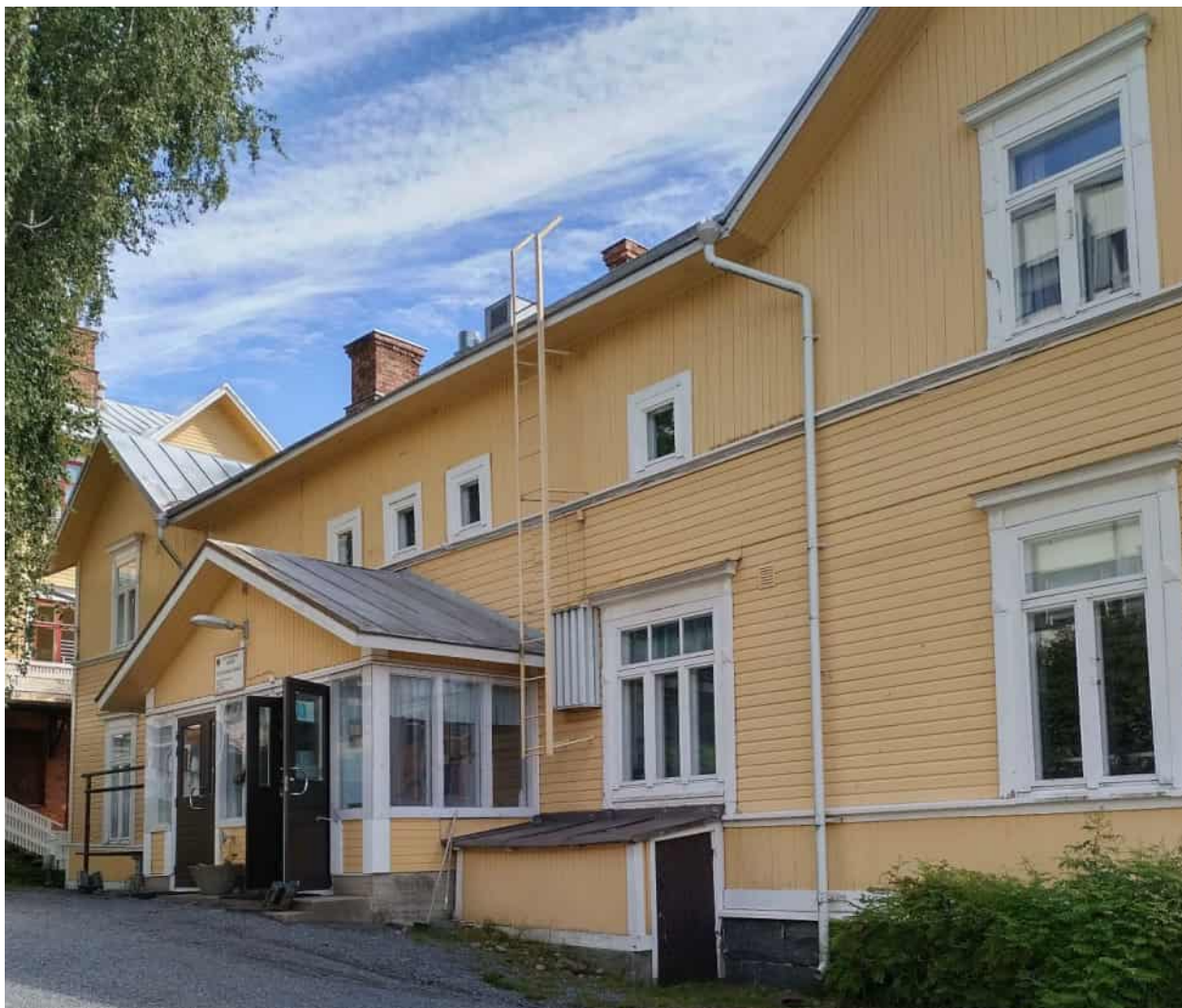
Kuva 26 Koulukatu 56 pihanpuoleisen rakennuksen kuisti ja julkisivu vuodelta 2021
