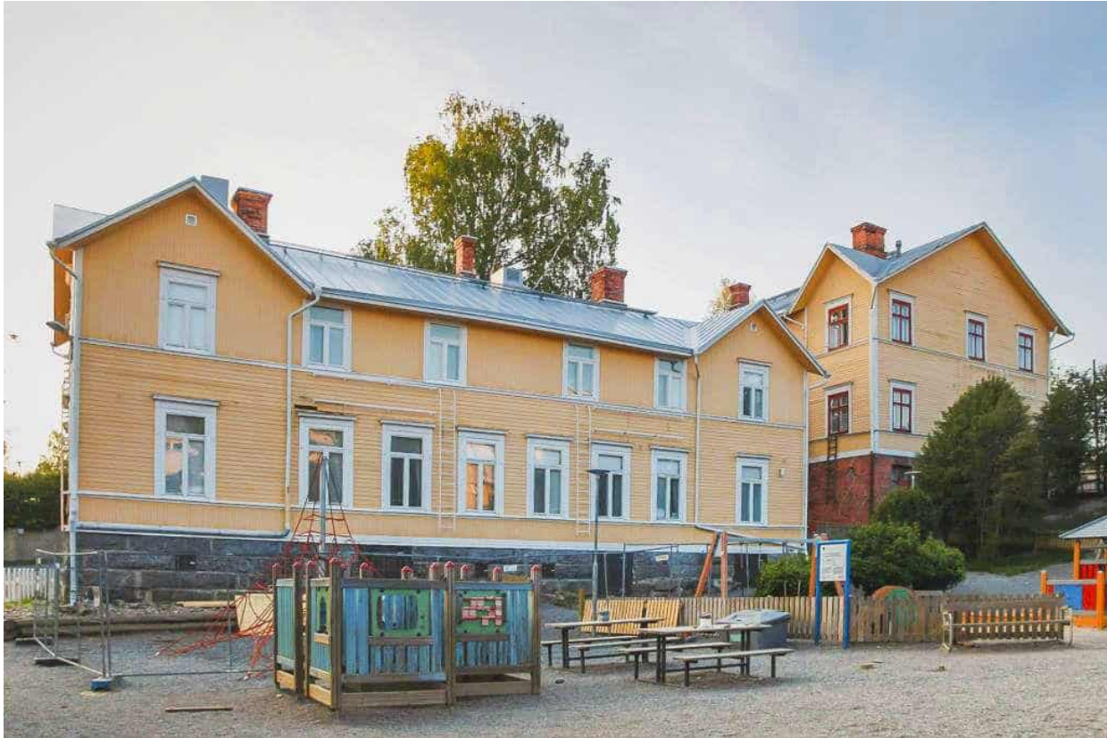
Kuva 31 Gustavsborgs daghem, Koulukatu 56 rakennukset leikkipihalta kuvattuna, kuva otettu Vaasan kaupungin verkkosivuilta
