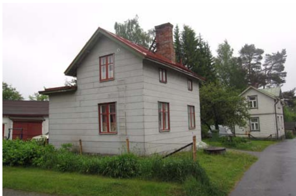
Vetokannaksen talot on rakennettu 1930- ja 2000-lukujen välisenä aikana. Nämä Gerbyntien varrella olevat talot on rakennettu 1930-luvulla ja kuuluvat näin ollen kaupunginosan vanhimpiin taloihin.
