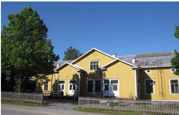
Kustaalan kaupunginosalle nimensä antanutta Villa Gustafsrö:tä ruvettiin rakentamaan 1850-luvulla. Rakennus on nykyään tyhjiään, mutta on aikaisemmin toiminut muun muassa kansakouluna ja lastenkotina.
