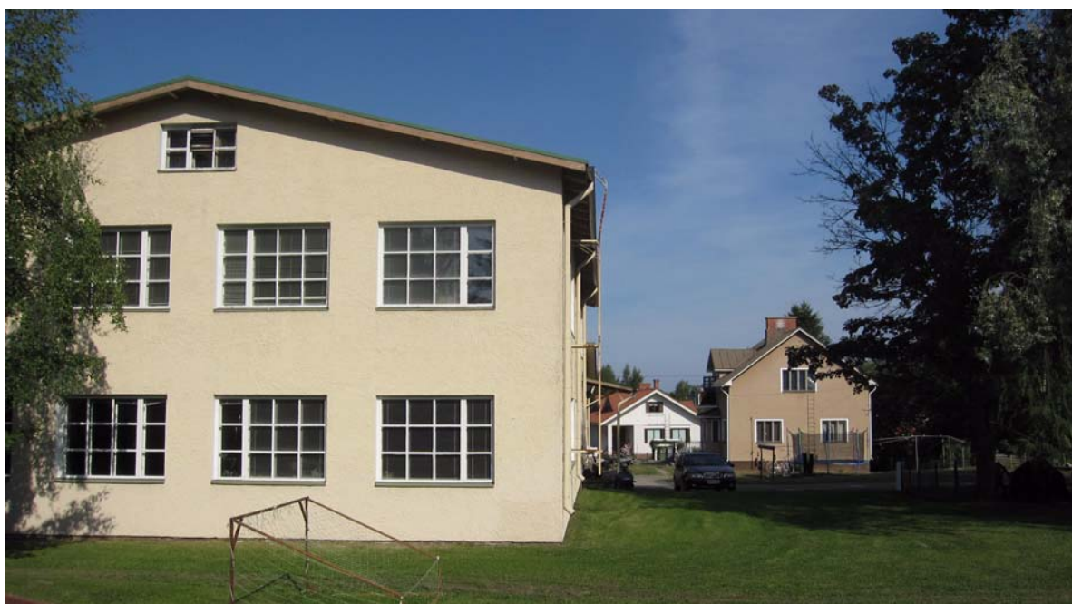
Paulatehdas on rakennettu vaiheittain. Vanhin osa vuodelta 1938 on Gunnar Granlundin suunnittelema.
