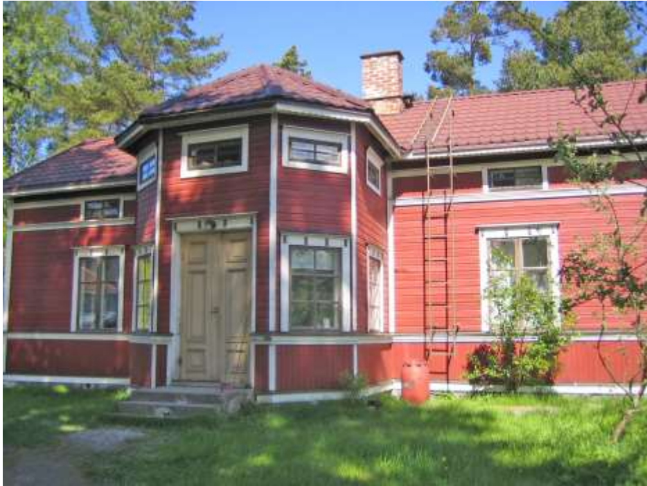
Valkoisin listoituksin osiin jaettu julkisivu, jossa pysty- ja vaakalaudoitusta. Sekä kuusiruutuisia että t-ikkunoita, joiden vuorilaudat koristeltu hillitysti. Keskuskatu 41, 23-4-1, rakennettu 1920
