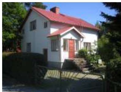
Mineriittilevyillä peitetty rakennus. Rakennettu vuonna 1955. Pellavatie 149, 2:215
