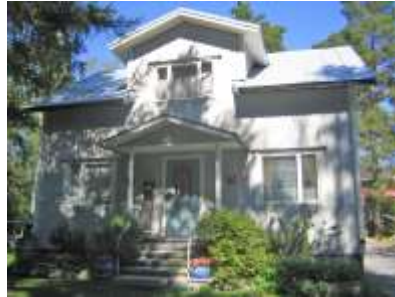
Puurakentamista 50-luvulla. Rakennettu vuonna 1957. Kytösavuntie 138, 2:140
