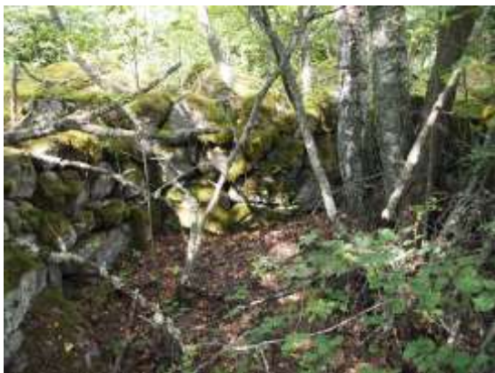
Kuva 31 Kivistä ladotut perustukset.
