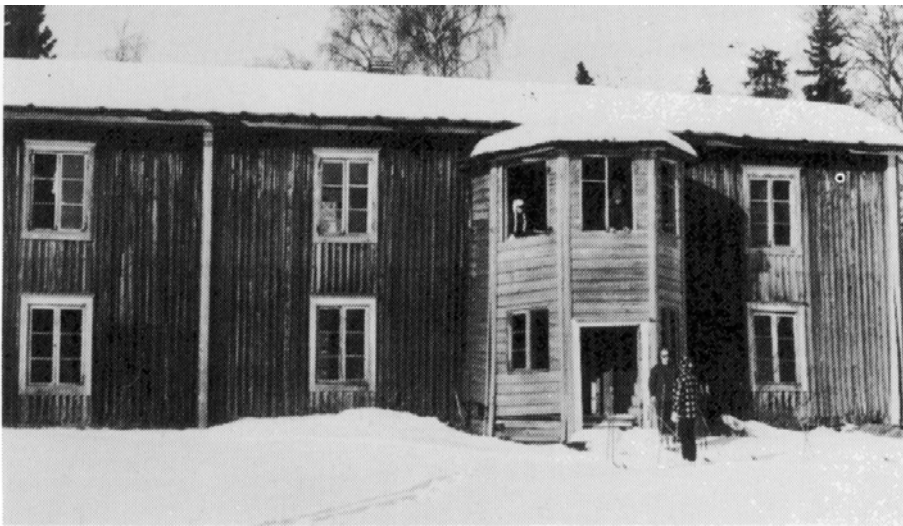
Långskärin metsänvartijan talo v. 1969. Rakennus on purettu 1970-luvulla.
