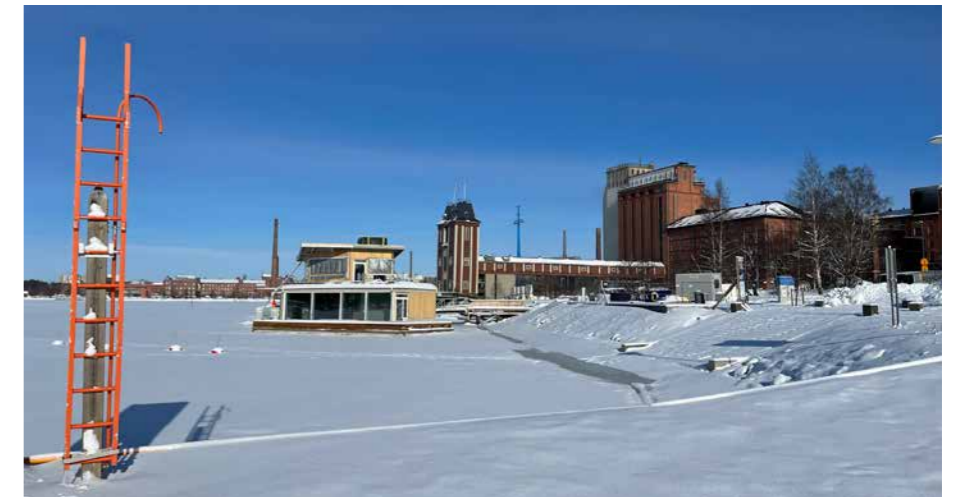
Kuva 101: Kelluvat rakenteet muokkaavat maisemaa meren suunnasta, sekä vie-reisiltä ranta-alueilta tarkasteltuna. Rakennustyömaa kuvattu maaliskuussa 2023.
