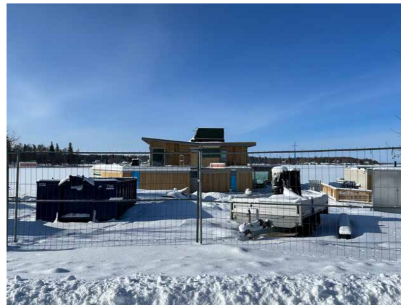
Kuva 83: Vaasan Kaupunginrannan edustalle rakentuu kelluva saunaravintola. Kuva otettu rakennustyömaan aikana maaliskuussa 2023.
