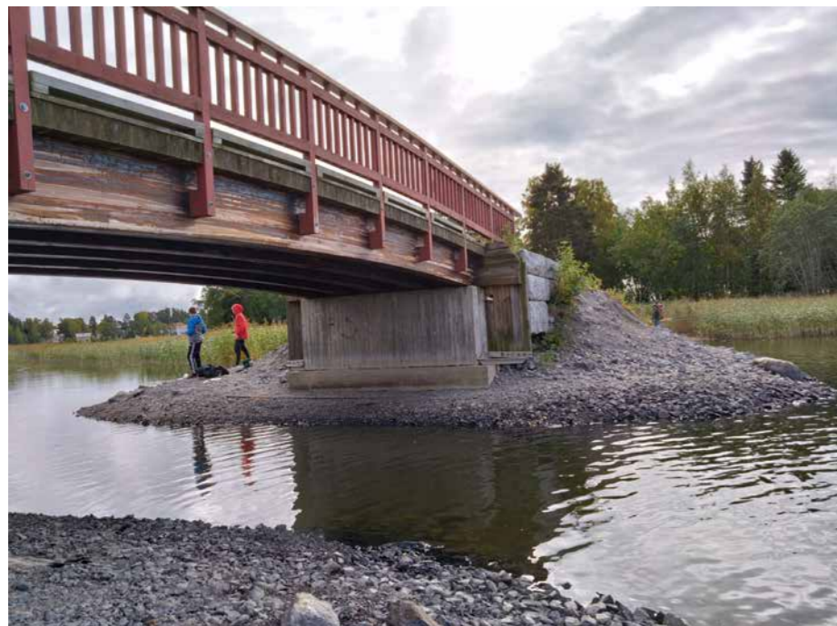
Kuva 78: Lapsia kalassa Variskarilla loppukesällä 2022. Meri vesi on matalalla ja sillan perustukset ovat paljastuneet.
