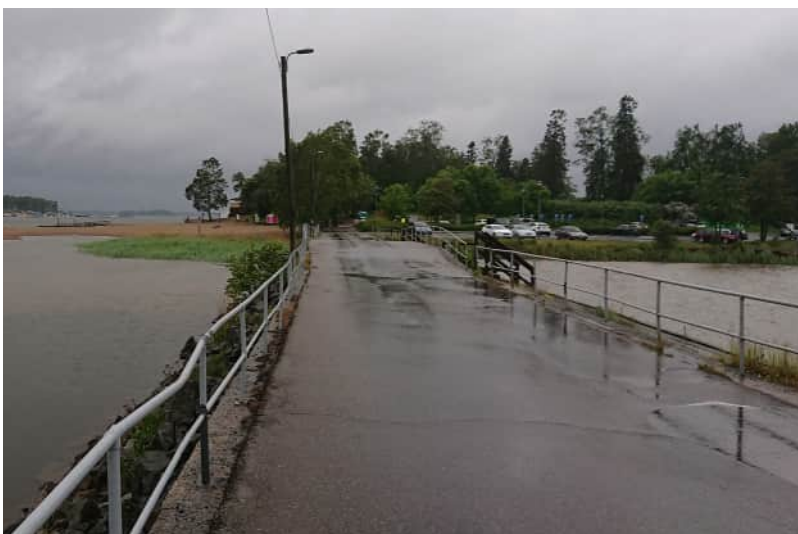
Kuva 48: Etenkin sateisella säällä sillan pinnan epätasaisuus kerää suuria lätäköitä ja hankaloittaa sillan kevyenliikenteen käyttöä. Sateinen päivä kesällä 2021.
