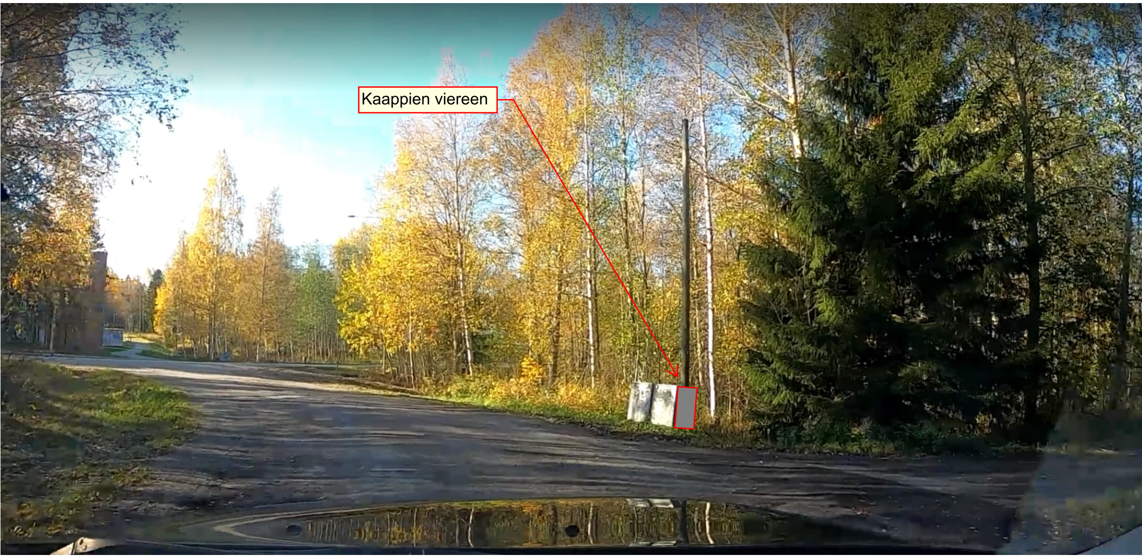
Kaappi 5 - Kirjurintie Flinkintie -risteys
