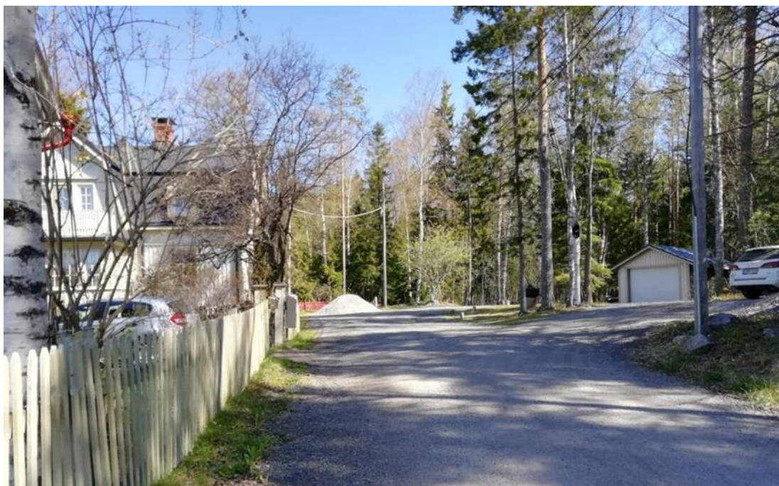
Månviksgatan och vändplatsen i ändan av den, i anslutning till vilken det finns ett garage och utrymme för parkering längs gatan, fotograferade våren 2021.
