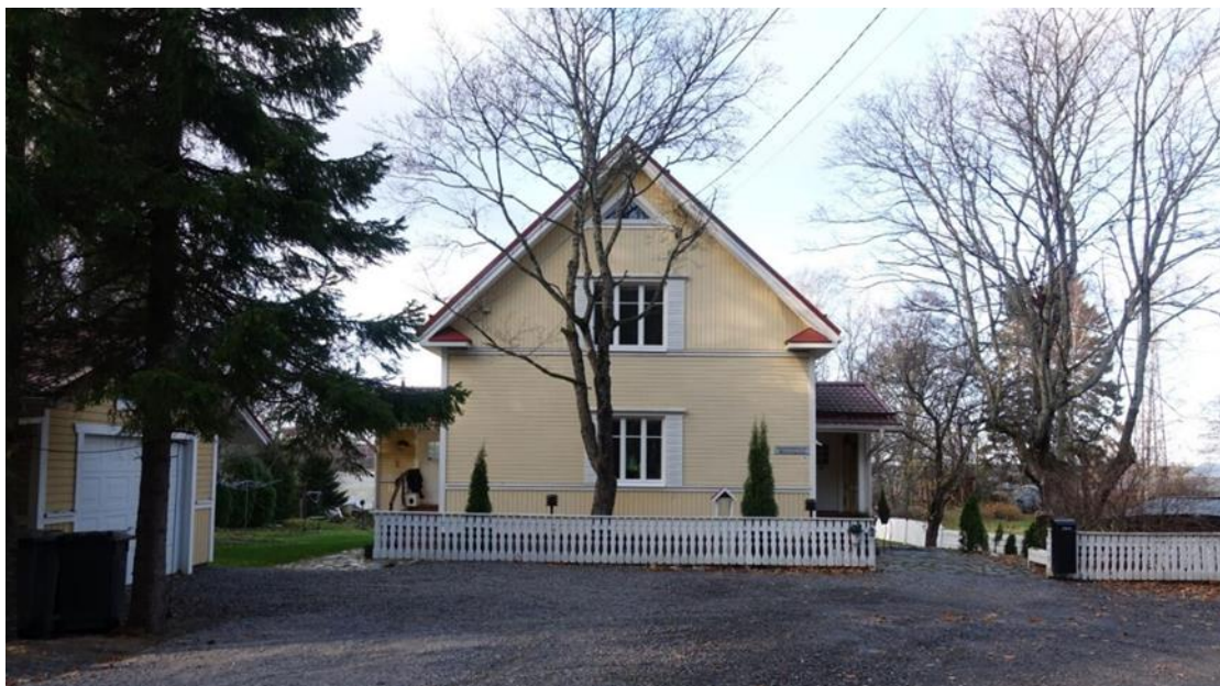
Huvudbyggnaden på Månviksgatan 10 och garaget bredvid den fotograferade från gatan hösten 2020.
