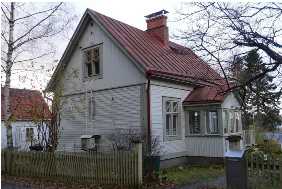
Kuulahdenkatu 6:n päärakennus kadulta kuvattuna syksyllä 2020. Kuvan ottamisen jälkeen aita on poistettu.
