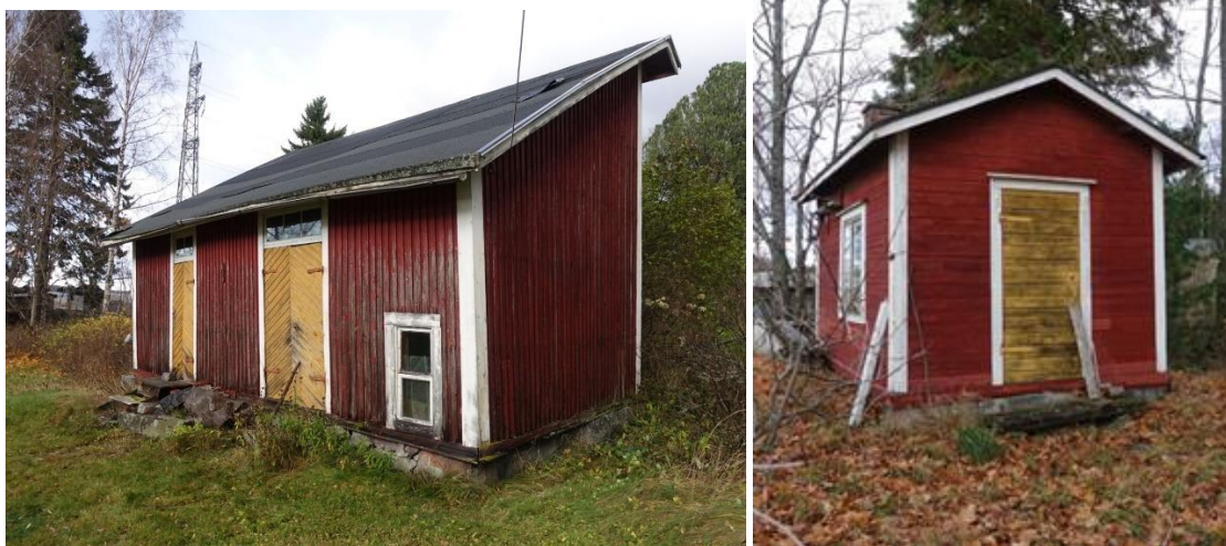
Päärakennuksen kanssa samoihin aikoihin rakennetut rakennus ja sauna kuvattuina syksyllä 2020.
