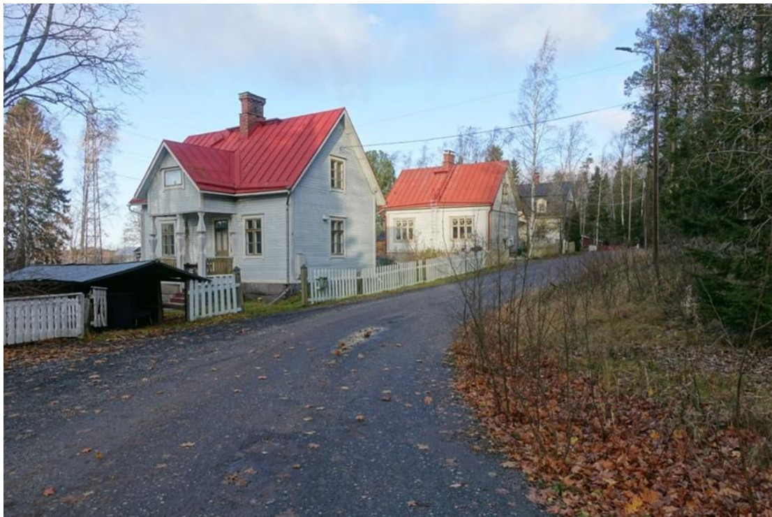
Kuulahdenkadun asuinrakennusten rivistö eri suunnista kuvattuna vuonna 2021.
