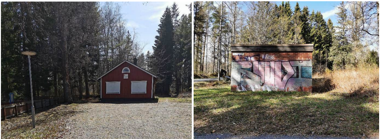
Kuvat: Avoimen päiväkodin rakennus (purettu) ja muuntamo.
