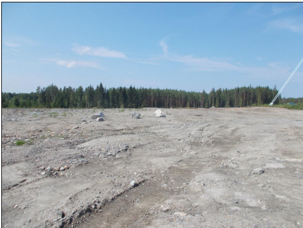
Kuva 4. Kohta, jossa maan pinta on selkeästi painunut.
