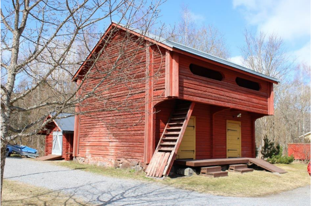
Kuva 81. Luhtiaitta pappilan suunnasta kuvattuna. Aitan takana (vasemmalla) on pienempi hirsirunkoinen varastorakennus.
