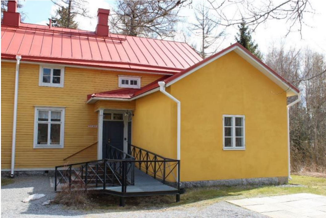
Kuva 60. Esteetön sisäänkäynti rakennuksen eteläpäättyyn ja holviosaan.
