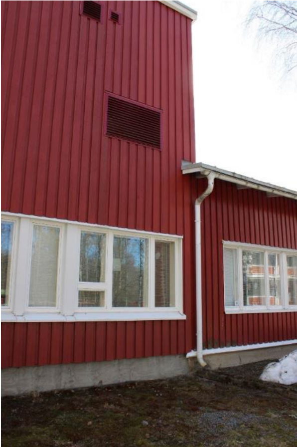
Kuva 96. Vanhan ja lisäosan yhdistymiskohta. Uudisosa on vanhaa osaa korkeampi.
