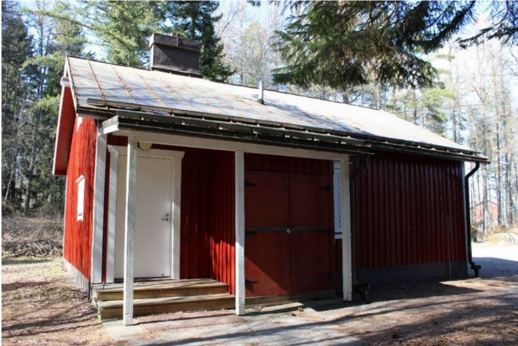
Kuva 108. Katettu sisäänkäynti rakennuksen kaakkoisjulkisivulla.
