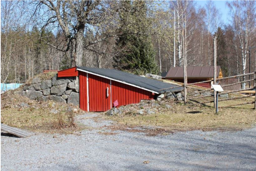
Kuva 42. Vanhaan höyrymyllyn kivijalkaan rakennettu varastotila.
