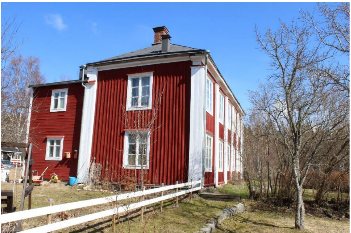
Kuva 33. Päärakennuksen länsi- ja eteläjulkisivuja.
