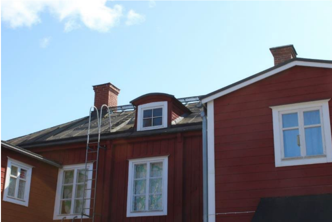
Kuva 36. Kattolyhdyn ikkuna on vaihdettu.
