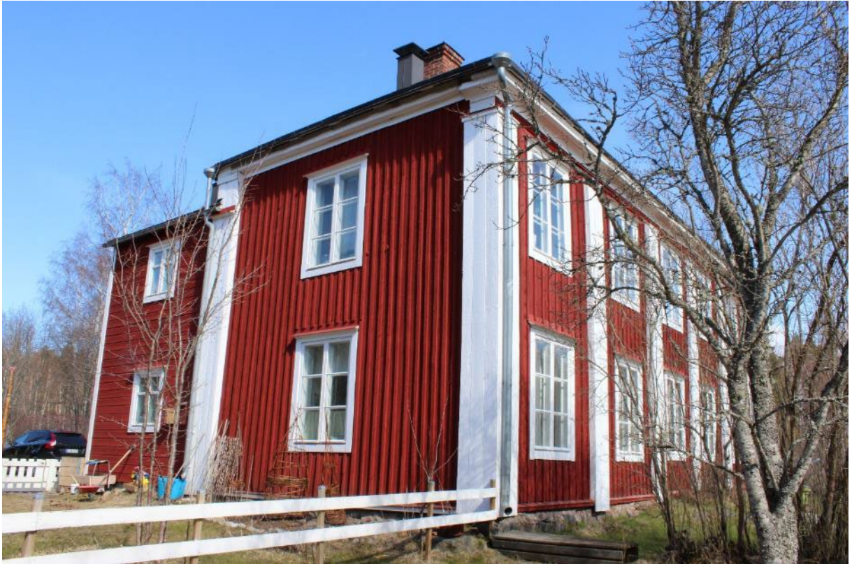
Kuva 34. Päärakennuksen länsi- ja eteläjulkisivuja.
