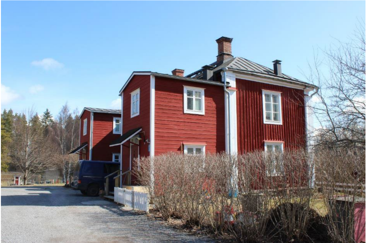
Kuva 32. Päärakennuksen länsi- ja pohjoisjulkisivuja.
