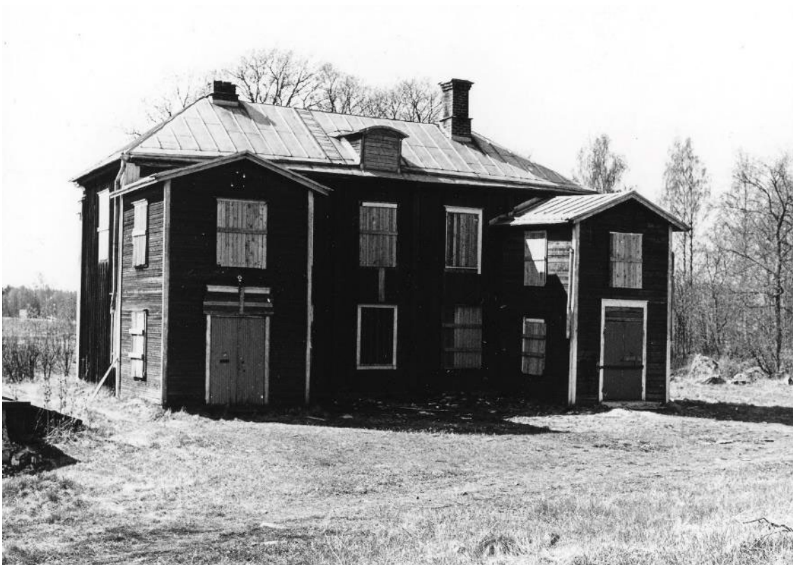
Kuva 29. Alkulan päärakennus vuonna 1983.
