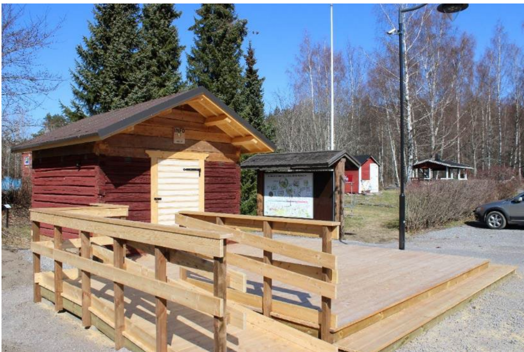
Kuva 41. Vanhasta hirsikehikosta rakennettu infokoppi, jonka edessä pyörätuoliluiska ja terassi (valmistunut 2023). Hirsikehikko tuotu muualta.
