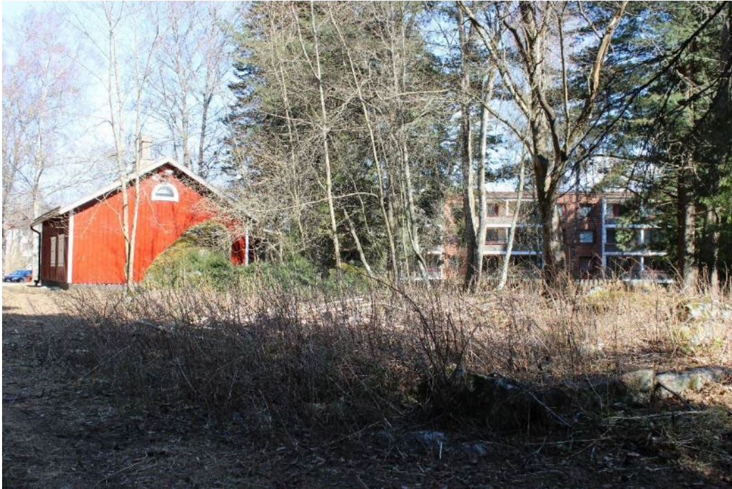
Kuva 106. Näkymä lounaan suunnasta. Etualalla näkyvissä puretun, pitkän talousrakennuksen kivijalkaa.
