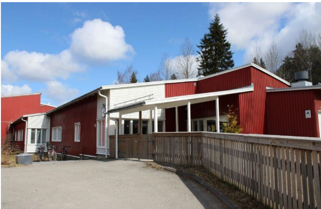
Kuva 89. Päiväkodin julkisivua lounaan puolella.
