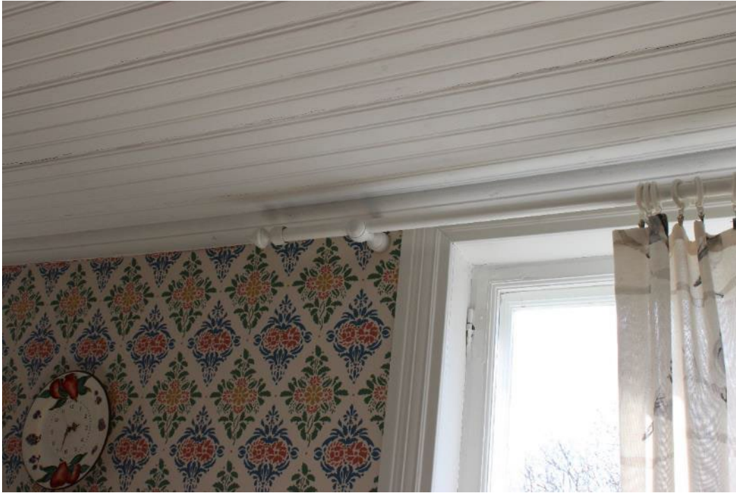
Kuva 48. Sisäkaton helmiponttipanelointi, ikkunoiden listoitukset ja puitteet ovat kaikki säilyneet ja kunnostettu.
