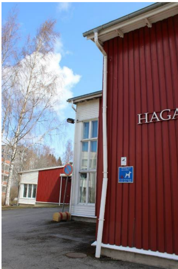
Kuva 93. Näkymä liikuntasaliosan nurkalta kohti koulun sisäänkäyntiä.
