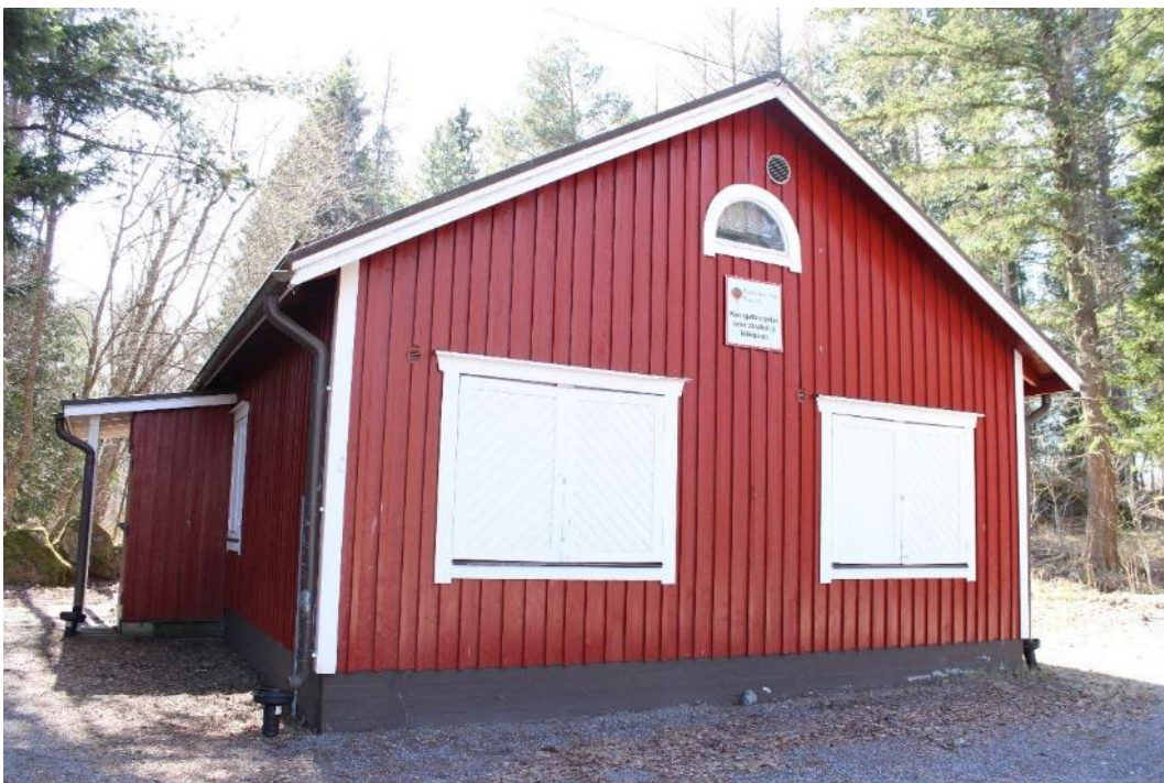
Kuva 109. Koillispuolen pääty, jossa alun perin oli sisäänajo talliin.
