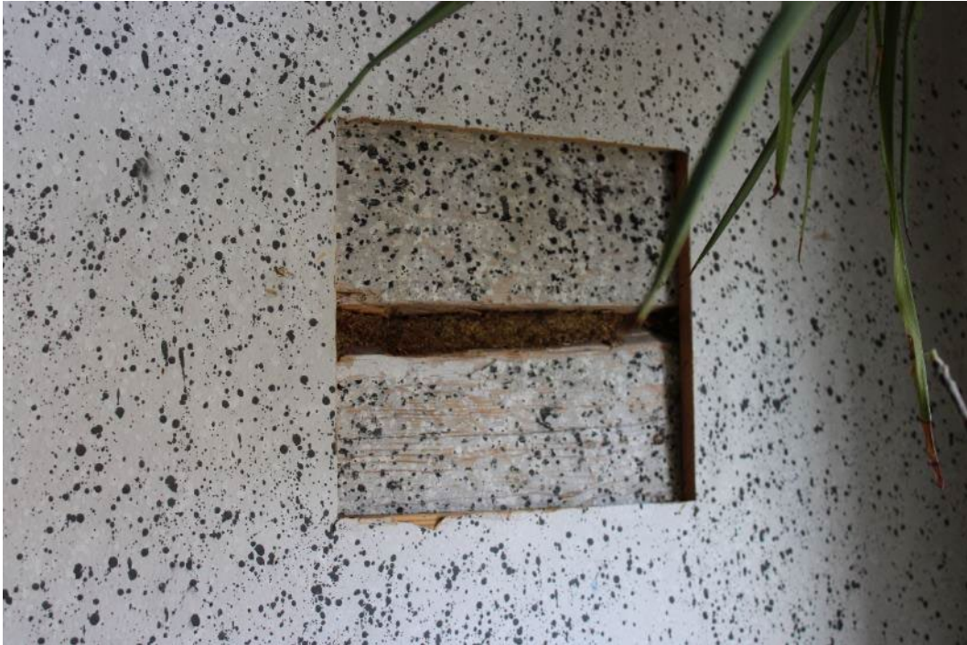
Kuva 50. Eteisen uusittua roiskemaalasta. Kurkistusluukusta näkyy vanhoja hirsiiä ja niiden eristeenä olevaa pellavarivettä.
