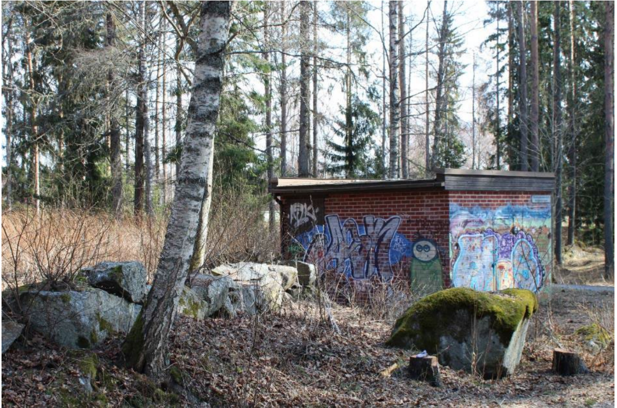
Kuva 115. Tiilinen muuntamorakennus Ristinummenraitin varrella.
