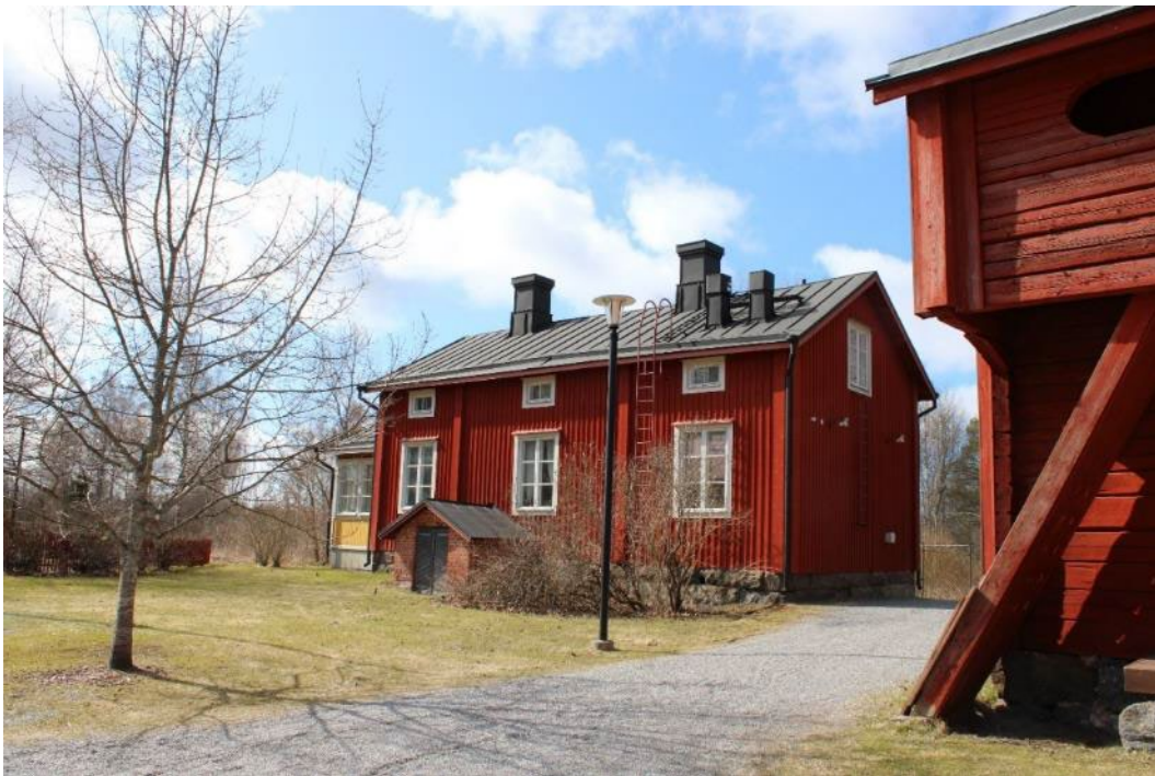
Kuva 78. Asuinrakennuksen itäjulkisivu ja pohjoispääty. Oikealla luhtiaitan nurkka.
