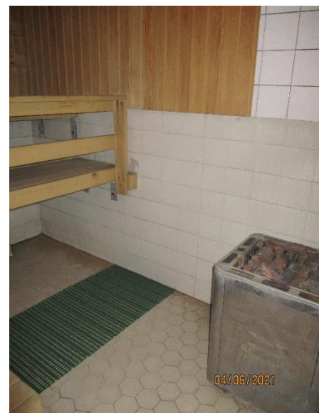
Kuva 44. Pesuhuone ja sauna
