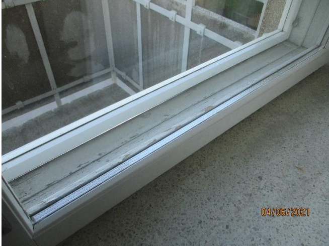
Kuva 56. Sisäpihan puolella olevat ikkunat
