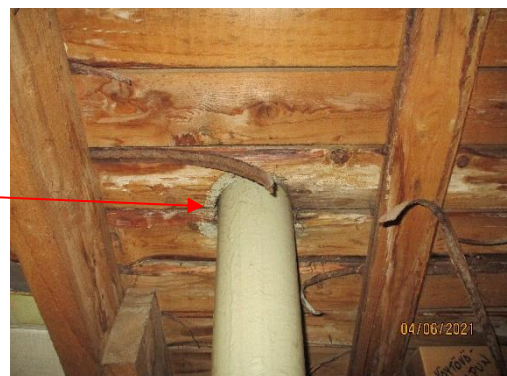
Kuva 36. Lämpivientejä jotka ovat epätiivit/tai vuotavat esiintyy vesikatolla.
