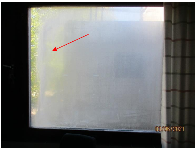
Kuva 18. "Maitoutunut" lämpölasit
