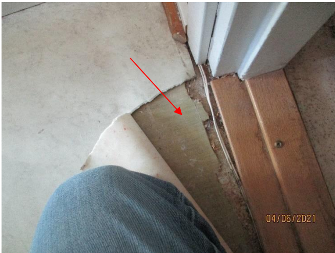
Kuva 61. Muovimaton alla alkuperäinen linoleumimatto.
