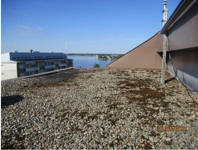
Kuva 1. Yleisnäkymä huopa katosta torni rakennuksen päällä
