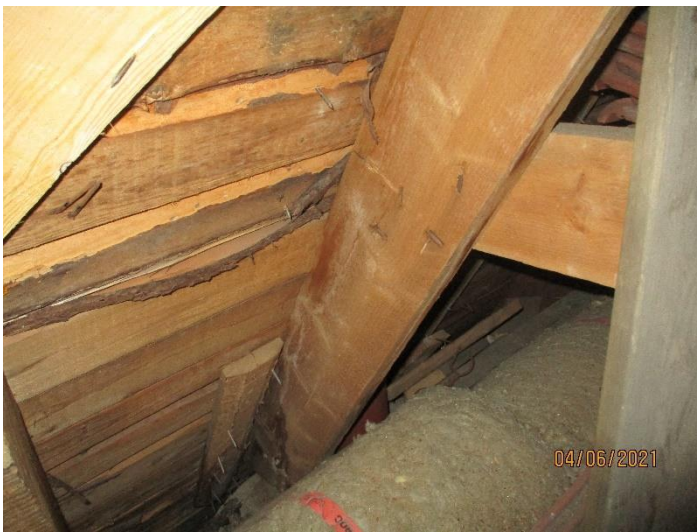
Kuva 38. Välikaton tuuletus räystäään kautta.
