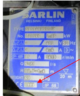
Kuva 30. Pumppaamo kellarin lattian alla, pumput vaihdettu 1999, kun 22 vuotta oli kulunut. Pumput nyt 21 vuotta vanhoja.
