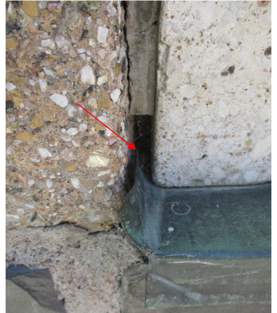
Kuva 51. Epätiivitä kiinnitysdetaljeja sekä liitoksia esiintyy julkisivussa
