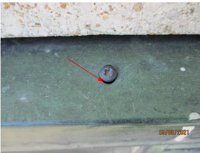
Kuva 51. Epätiivitä kiinnitysdetaljeja sekä liitoksia esiintyy julkisivussa
