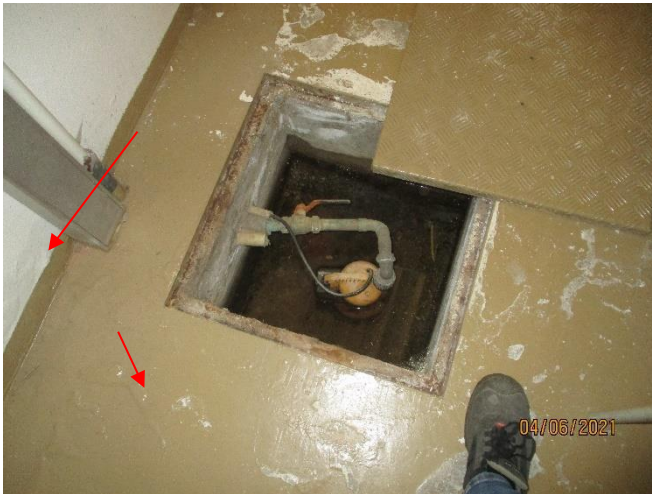
Kuva 40. Pohjavesipumppu
