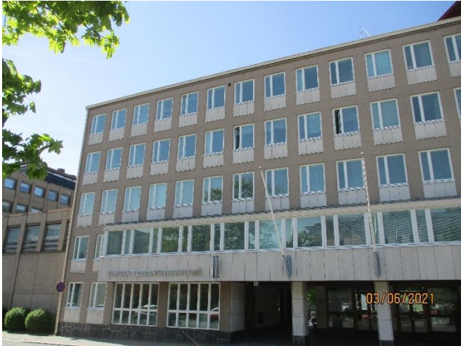
Kuva 53. Koulukadun puoleinen julkisivu.
