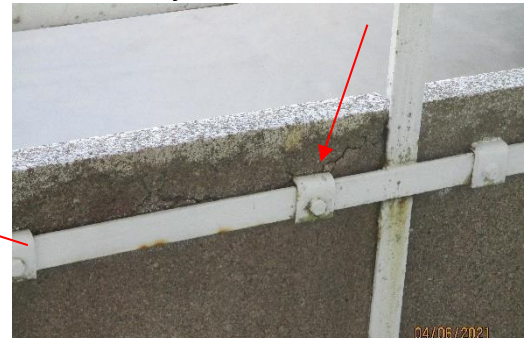
Kuva 48. Parvekkeet Parvekkeiden kaiteet ovat mustaa teräksestä ja siihen kiinnitetty betonilaattoja. Katso halkeamat
