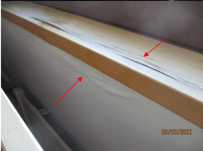
Kuva 19. Vuotojälkiä ikkunoista
