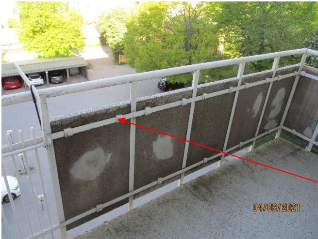
Kuva 48. Parvekkeet Parvekkeiden kaiteet ovat mustaa teräksestä ja siihen kiinnitetty betonilaattoja. Katso halkeamat
