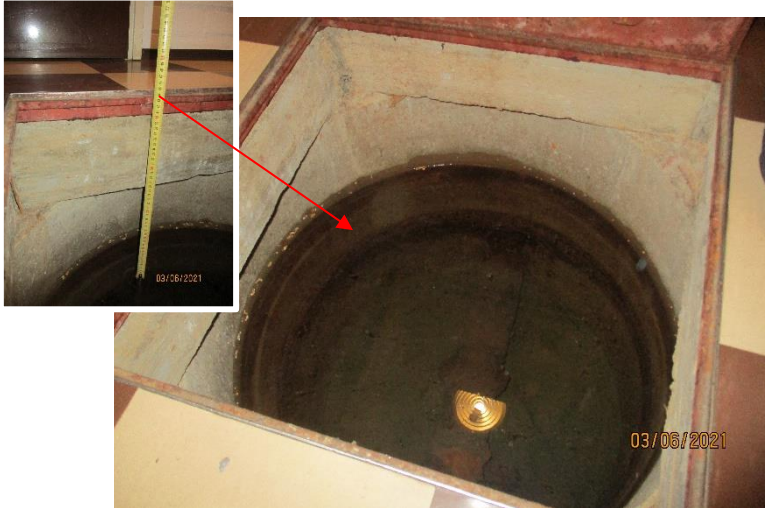
Kuva 7. Viemärin tarkastuskaivo kellarissa.
