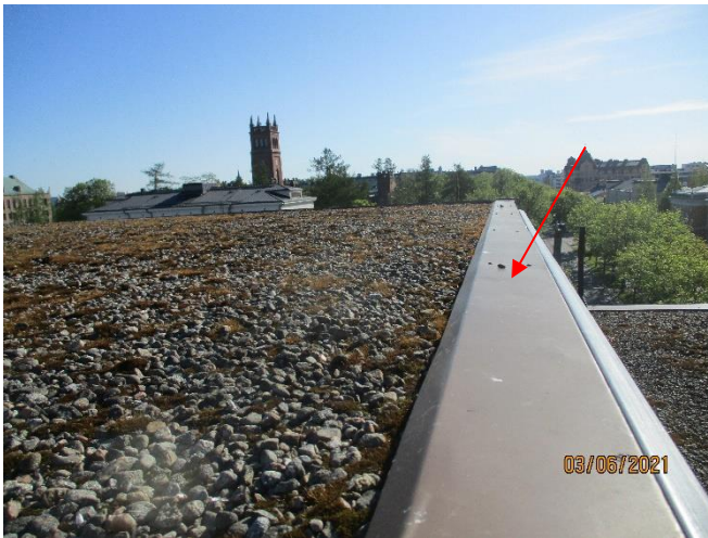
Kuva 2. Kattoreunat ovat matalia.
