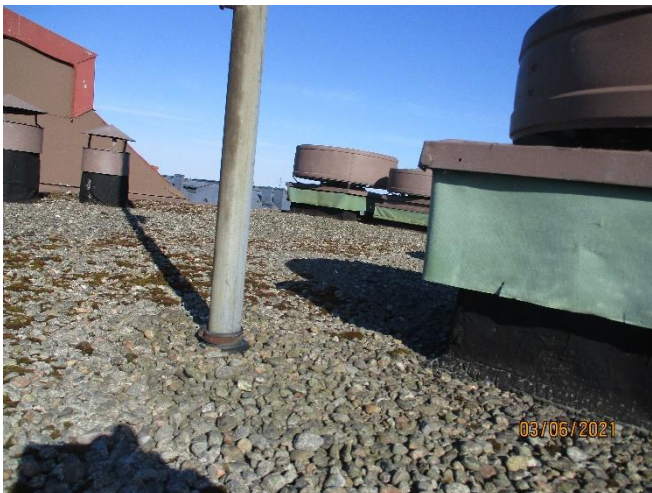
Kuva 3. Vesikatolla esiintyy runsaasti läpivientejä.
