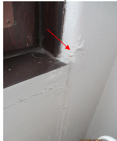
Kuva 19. Vuotojälkiä ikkunoista
