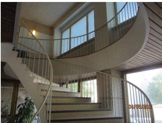
Kuva 65. Kirkkoherran viraston päänsisäänkäynti
