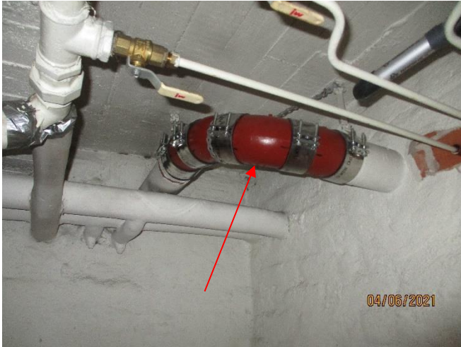
Kuva 72. Viemäreitä on korjattu kun vuotoja on syntynyt.
