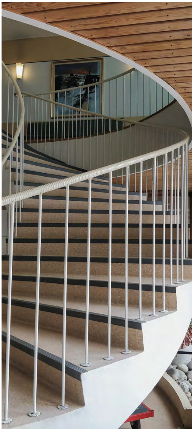
Keskinen porras, Koulukatu 26. Kuva: NAC arkkitehdit Oy, 2021.
