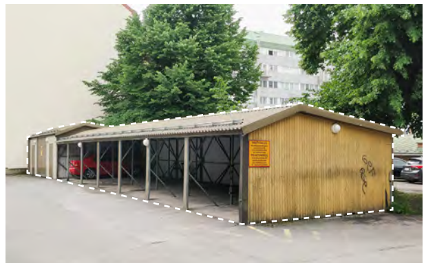
1996 Uusi autokatos Kuva: NAC Arkkitehdit Oy, 2021
