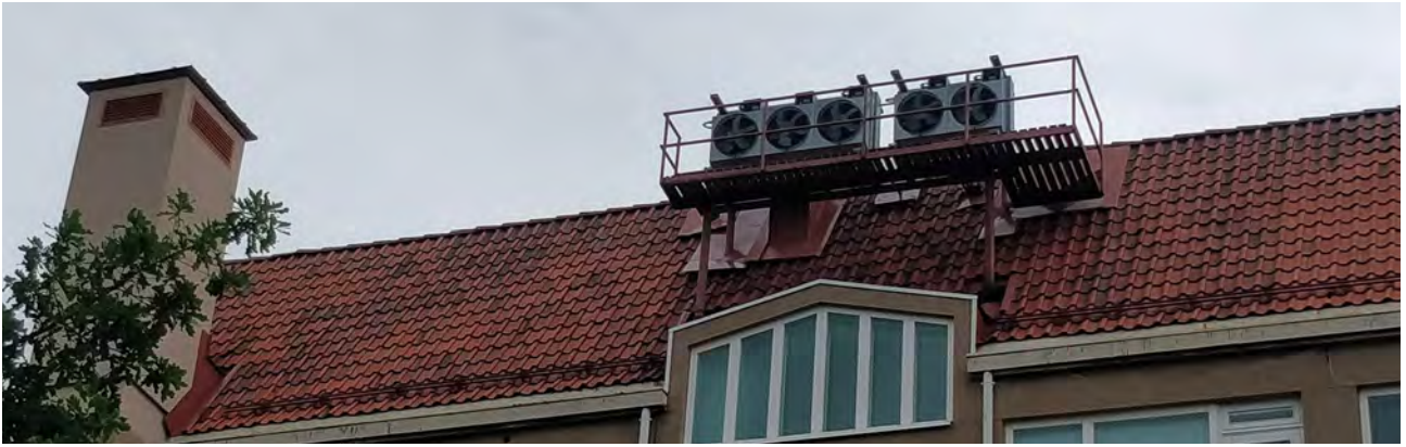
Uusi kattoluukku, kattosilta ja kaide vuodelta 1998. Kuva: NAC arkkitehdit Oy, 2021.
