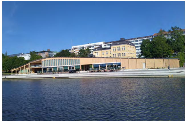
Kalastuksen talo. Kuva NAC Arkkitehdit Oy 2021.
