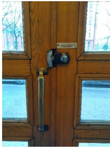
Kuvat 53 ja 54: Pääsisäänkäynnin sisäpuolinen käytävä ja lähikuva ovenkahvasta. Alkuperäiset materiaalit ovat laadukkaita ja ne ovat kestäneet aikaa hyvin.
