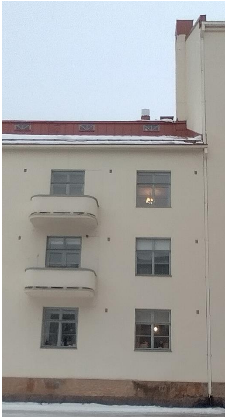
Kuva 43: Parvekkeet sulautuvat rapattuun julkisivuun pyöristettyjen kulmiensa ansiosta. Kuva otettu Taiteilijankujalta joulukuussa 2022.
