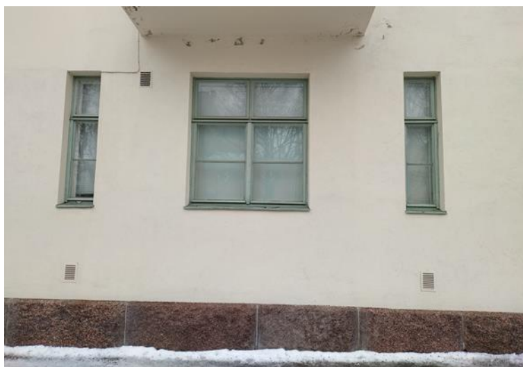
Kuva 44: Vaasapuistikonpuolella 6-ruutuiset ikkunat vuorottelevat kapeiden ikkunoiden kanssa. Kuva otettu joulukuussa 2022.
