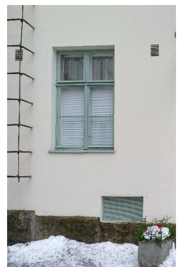
Kuva 45: Sisäpuoleinen 6-ruutuinen kapealinjaisempi ikkuna
