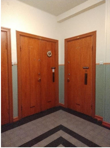
Kuvat 62 ja 63: Porrastasanteet ovat laattapinoitettuja.
