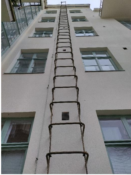
Kuvat 50 ja 51: Metalliset paloportaat johtavat sisäpihalta katolle. Kuvattu marraskuussa 2022.
